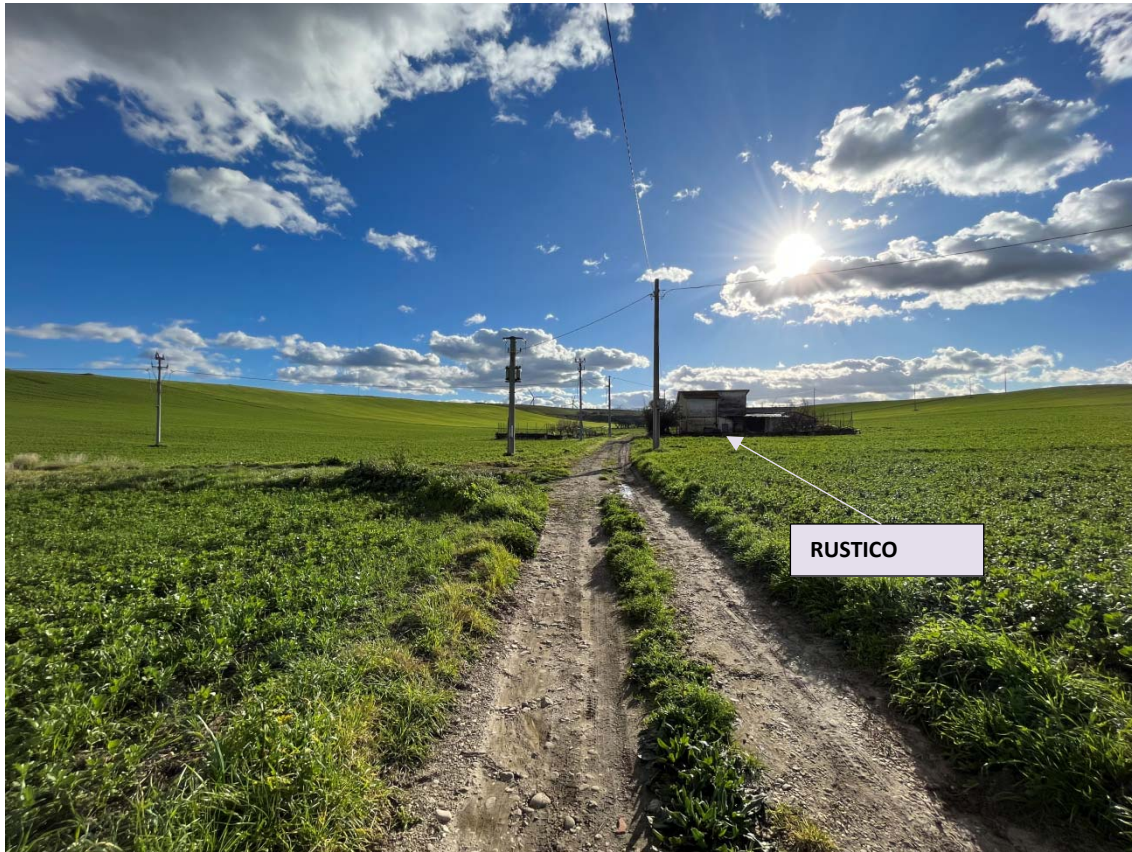
Figura 8: : Gruppo di edifici da demolire nel lotto 1, vista sud
