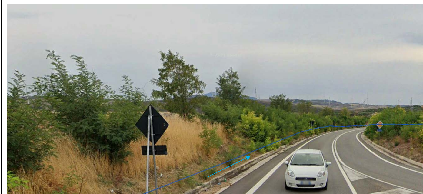
Punto foto "G4": Strada provinciale MELFI-SATAe Vista del tracciato del cavidotto interrato AT
