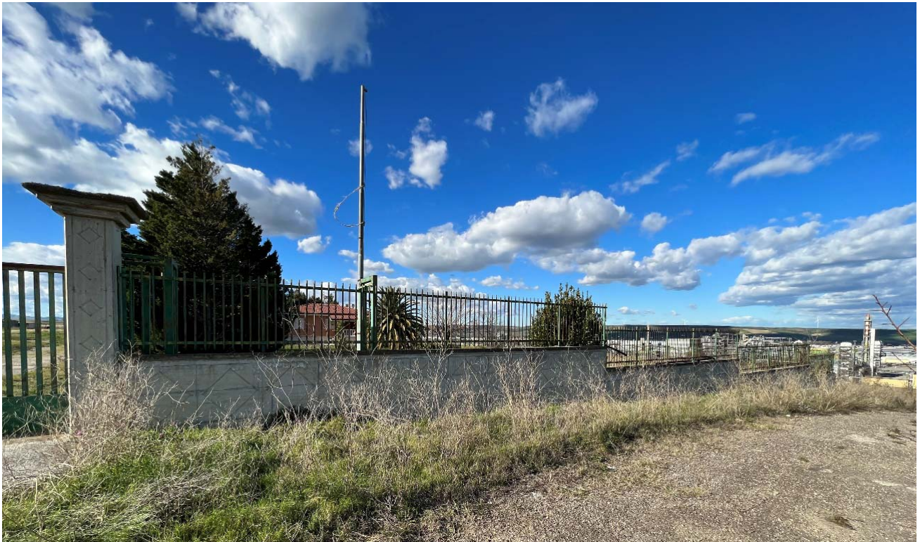
Figura 11: Vista est dei manufatti da demolire nel lotto 3
