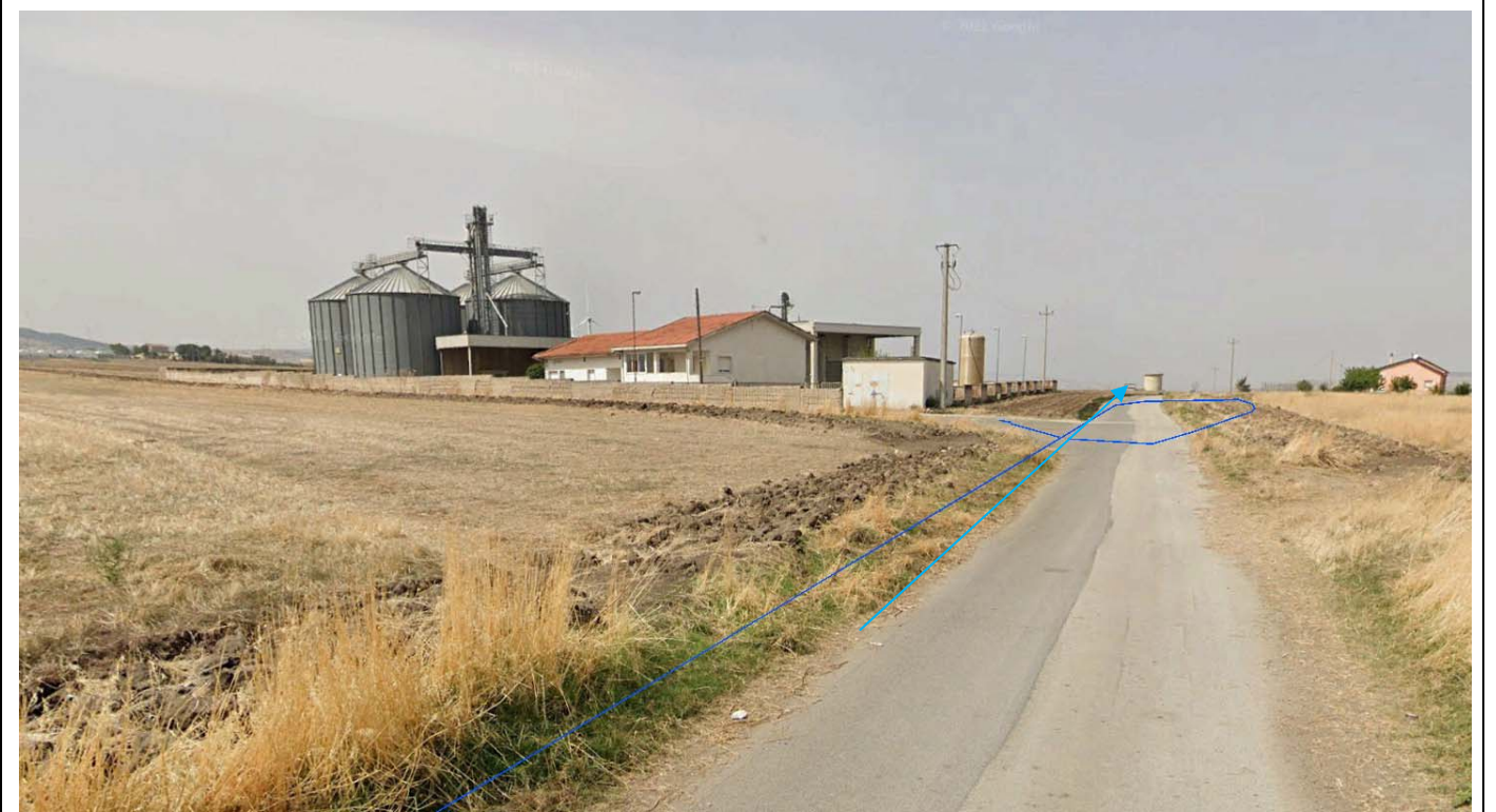
Punto foto "G6": Vista del tracciato del cavidotto AT su strada comunale in prossimità staz TERNA Esistente
