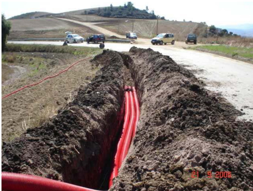
Figura 14: Foto illustrativa della messa in posa dei cavidotti MT
