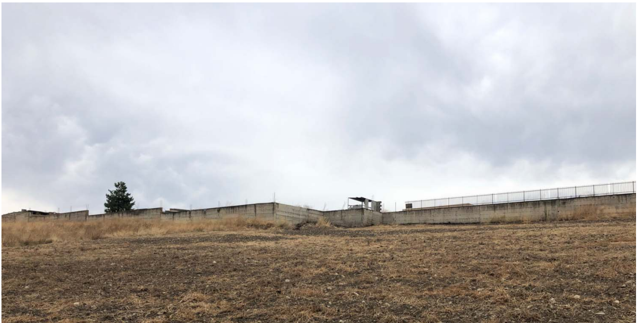
Figura 12: Vista sud dei manufatti da demolire nel lotto 3
