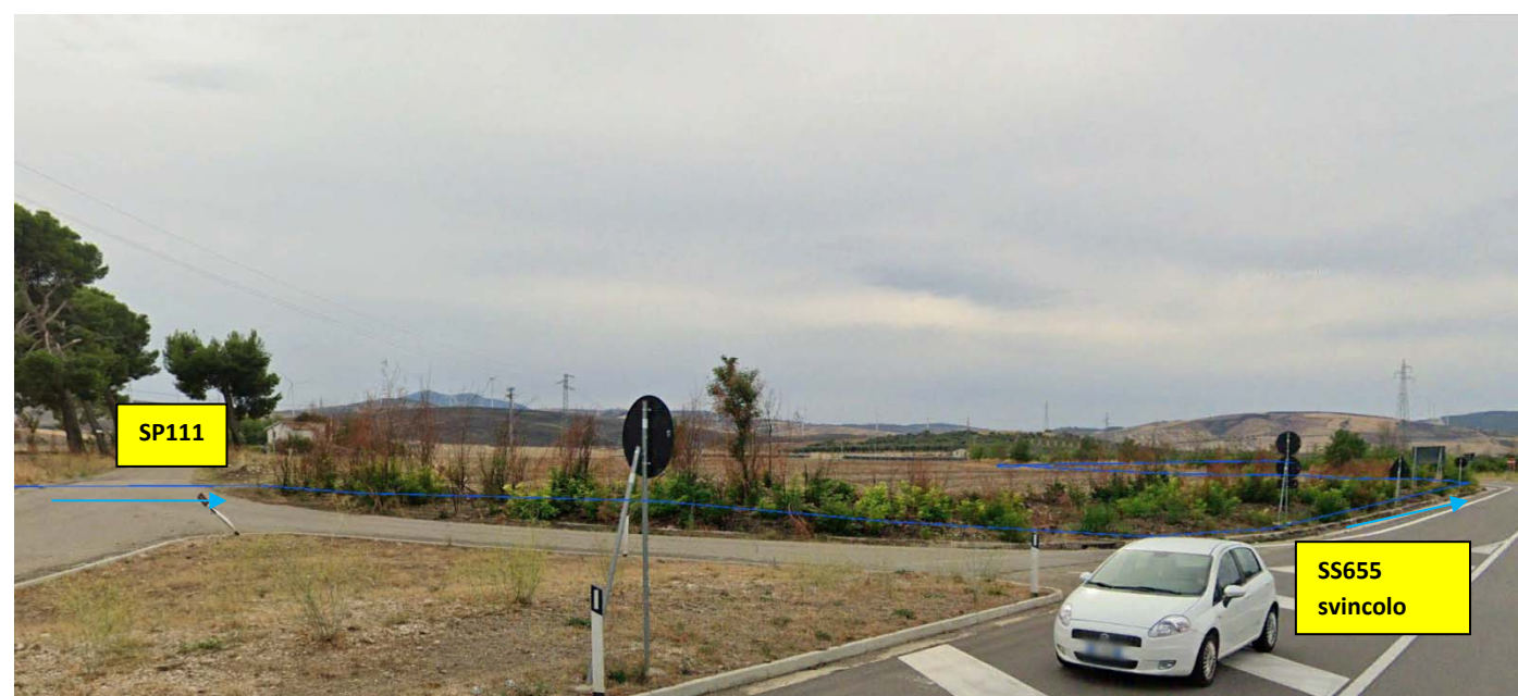
Punto foto "G3": omplanare e svincolo della SS655 vista del tracciato del cavidotto interrato AT
