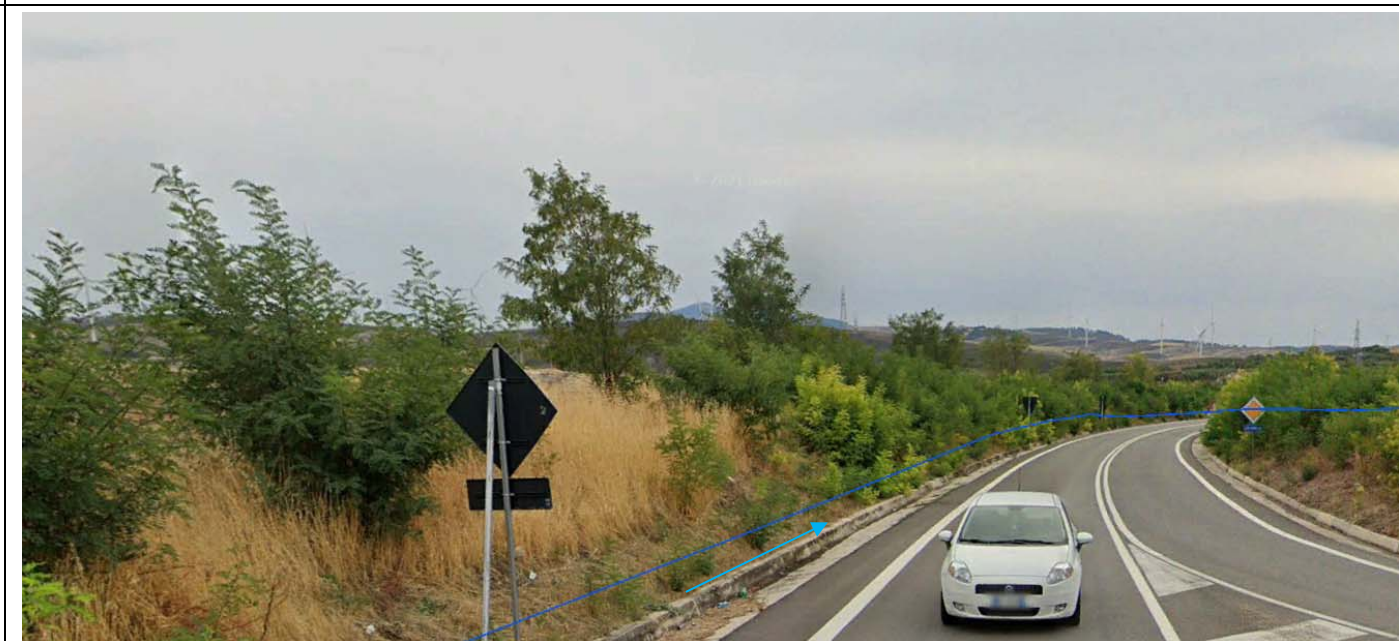
Punto foto "G4": Strada provinciale MELFI-SATAe Vista del tracciato del cavidotto interrato AT
