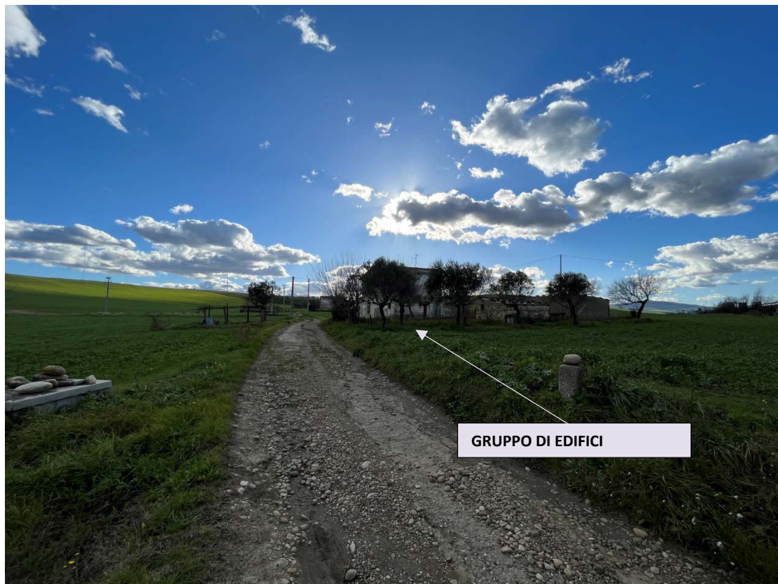
Figura 64: Rustico da demolire nel lotto 1, vista nord
