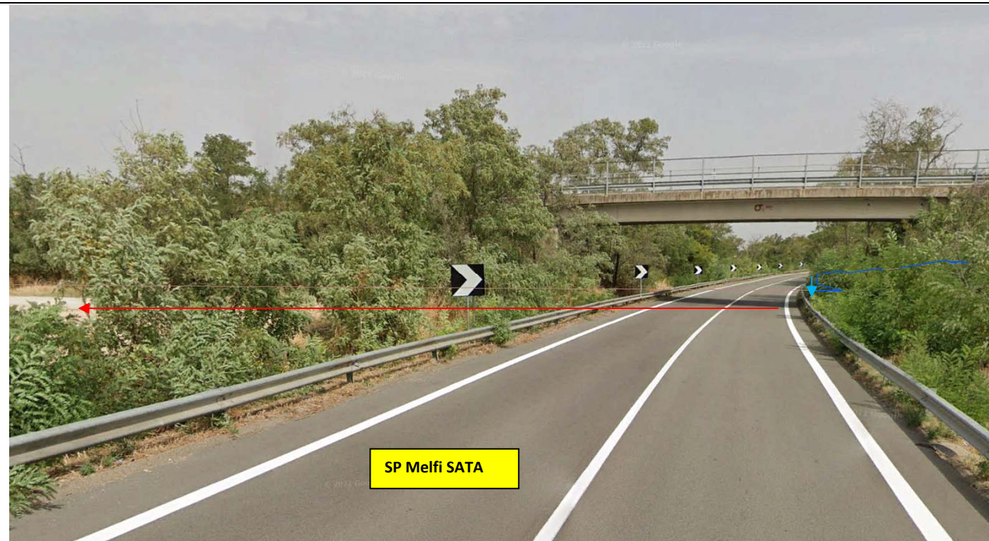
Punto foto "G5": Vista del tracciato del cavidotto AT in attraversamento (TOC) della SP MELFI SATA verso strada sterrata
