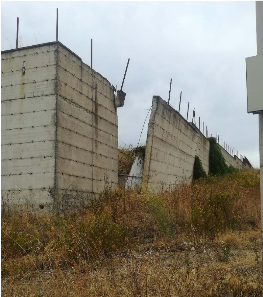
Figura 70: Vista ovest dei manufatti da demolire nel lotto 3, particolare della recinzione in decadimento
