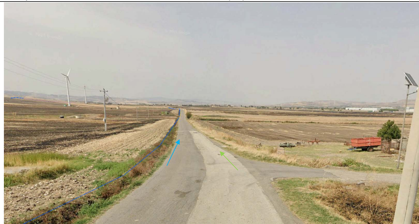
Punto foto "G7": Vista del tracciato del cavidotto AT su strada comunale verso la nuova SE TERNA
