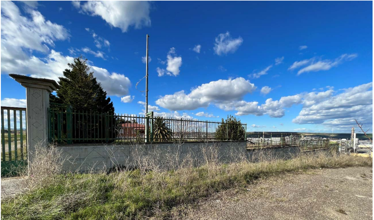
Figura 68: Vista est dei manufatti da demolire nel lotto 3
