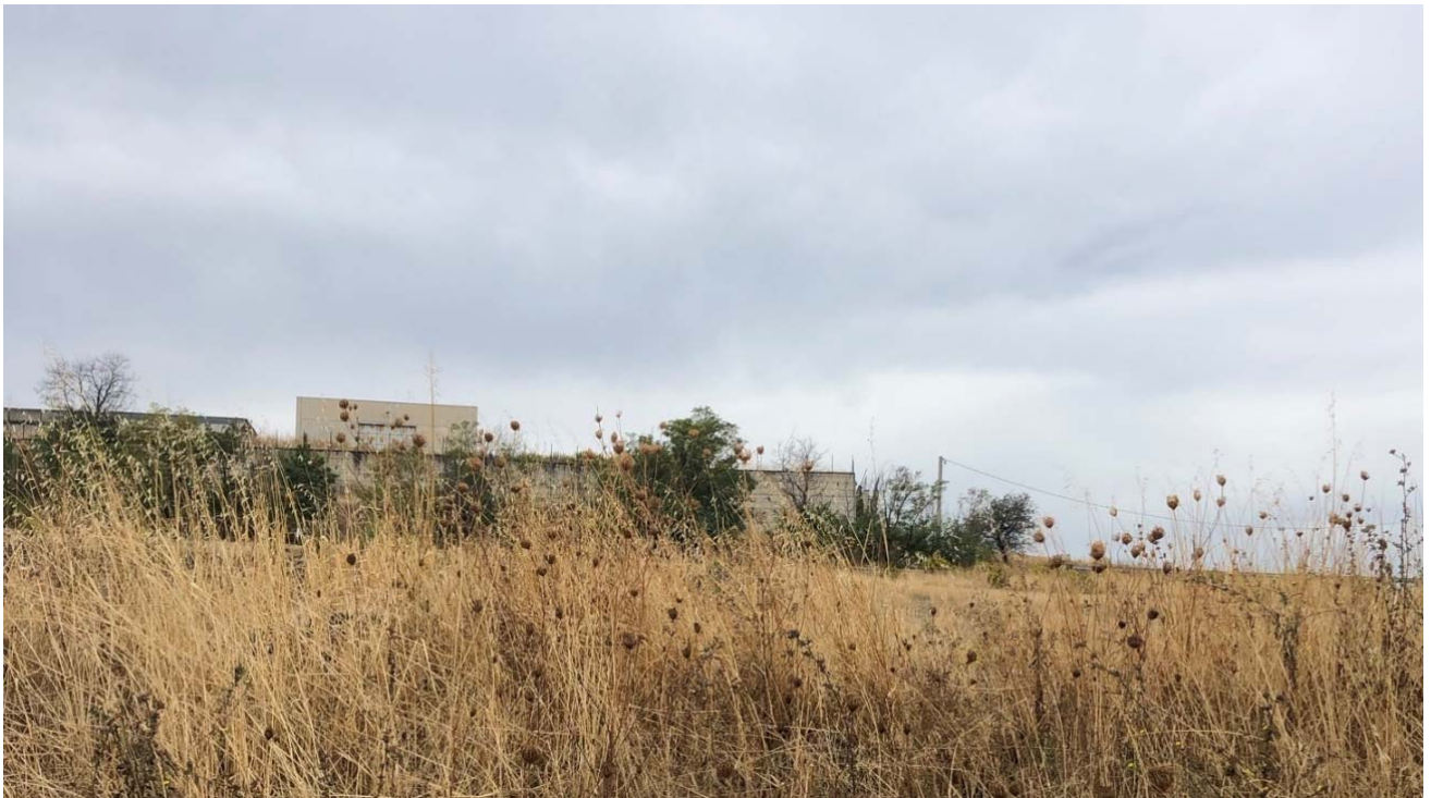
Figura 67: vista nord dei manufatti da demolire nel lotto 3
