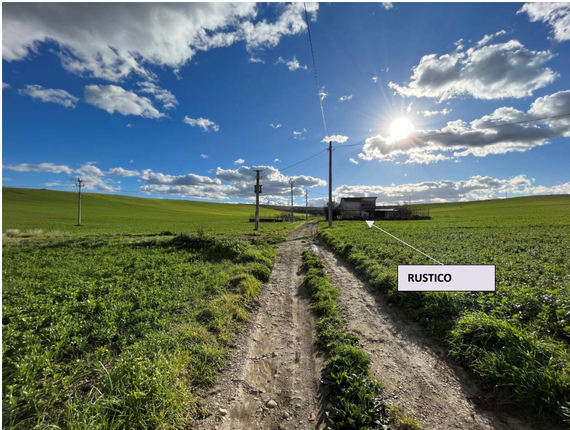
Figura 65: : Gruppo di edifici da demolire nel lotto 1, vista sud
