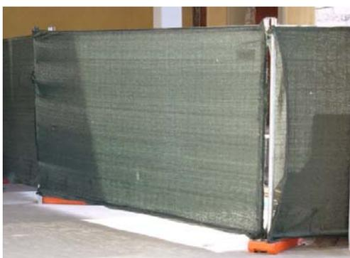
*Figura 79: Telo antipolvere da cantiere*
