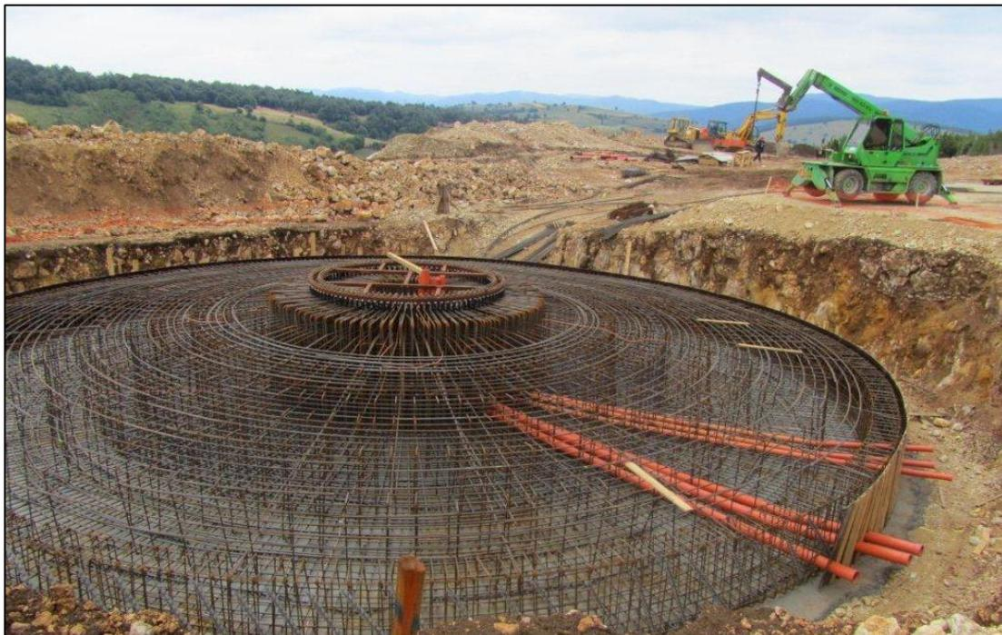
Figura 16 – Fondazione circolare diretta di un aerogeneratore in fase di costruzione
