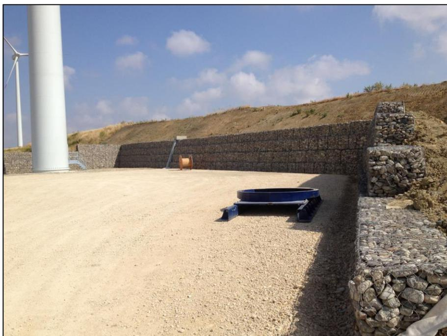
Figura 20 – Esempio di gabbionate a sostegno delle scarpate di scavo di una piazzola di stoccaggio e montaggio
