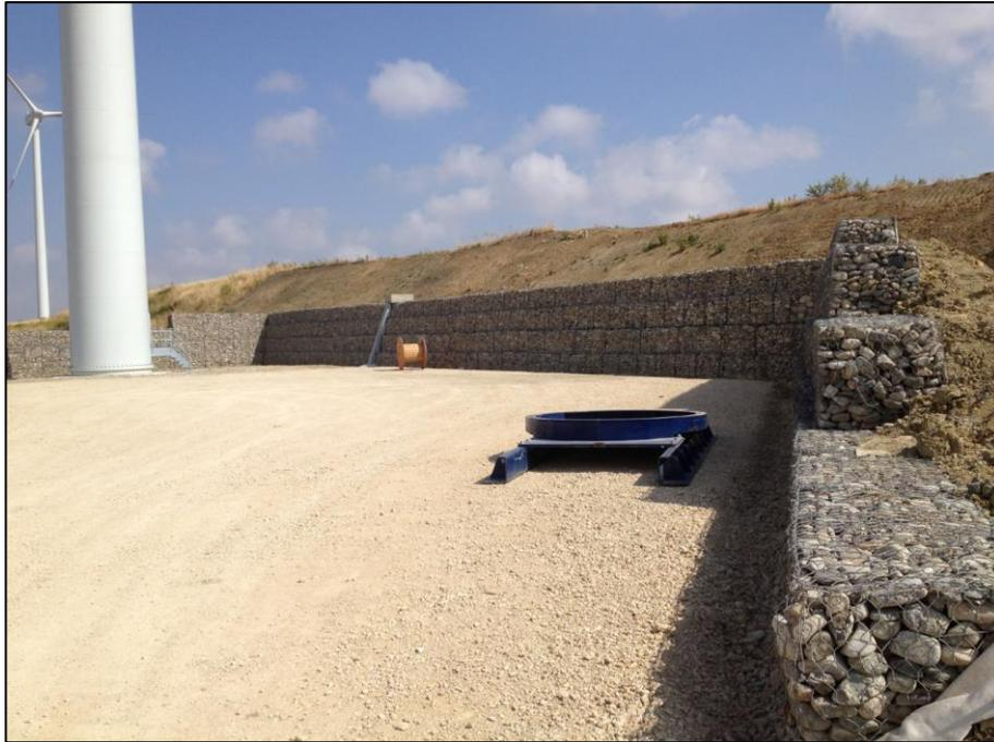
Figura 21 – Esempio di gabbionate a sostegno delle scarpate di scavo di una piazzola di stoccaggio e montaggio
