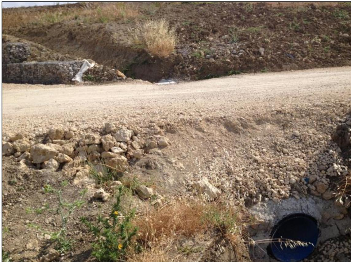
Figura 13 – Esempio di attraversamento stradale con tubazione circolare come in Figura 12
