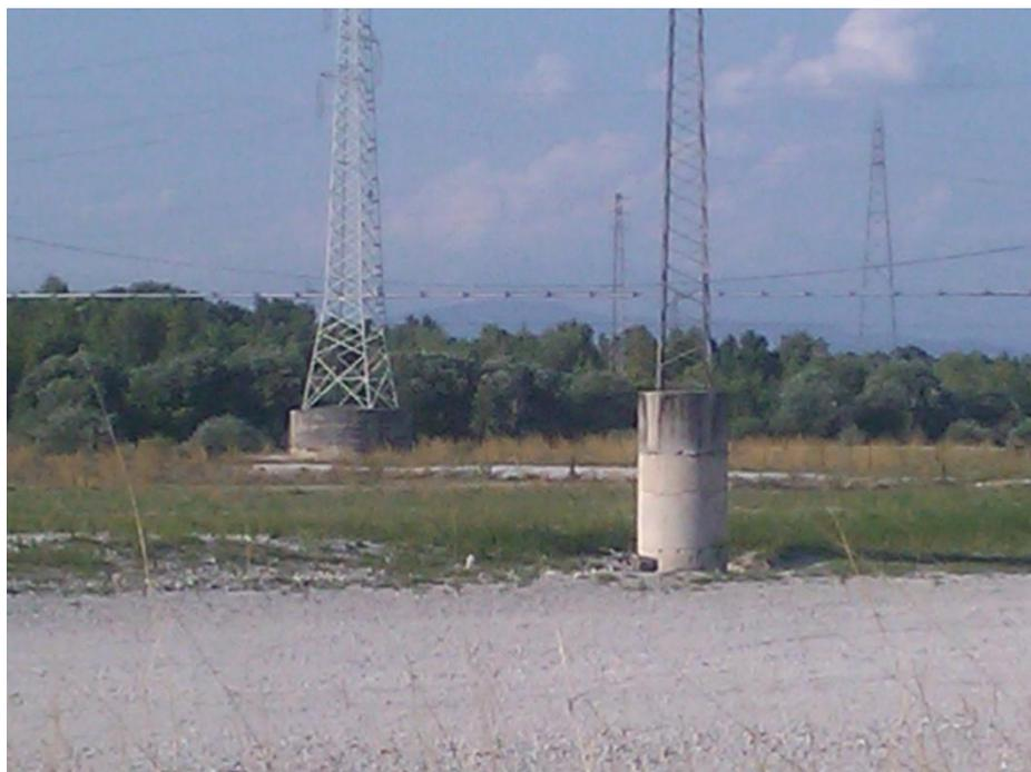
Si annota che il contestuale posizionamento di tutti i sostegni all'interno dell'alveo, a valle del viadotto autostradale, consente di evitare ulteriori analisi idrodinamiche, nei confronti dell'opera infrastrutturale interessata.
