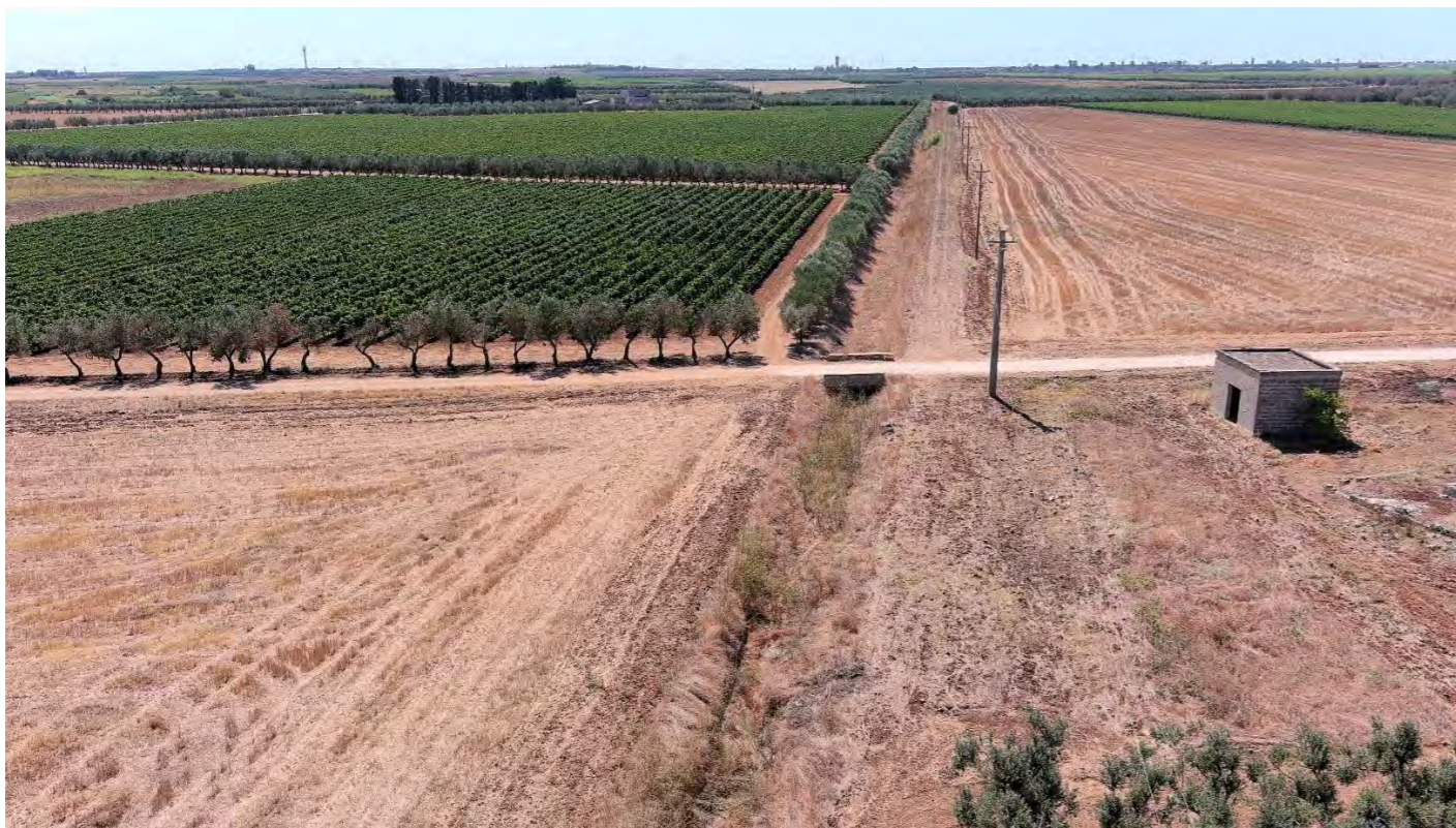
Vista da NORD
