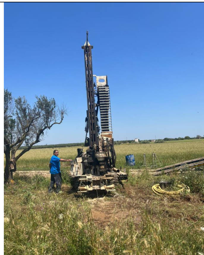
Postazione ed Esecuzione sondaggio S1 – aerogeneratore N05
