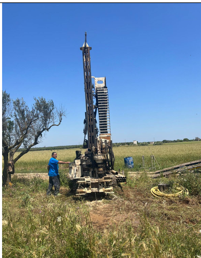
Postazione ed Esecuzione sondaggio S1 – aerogeneratore N05
