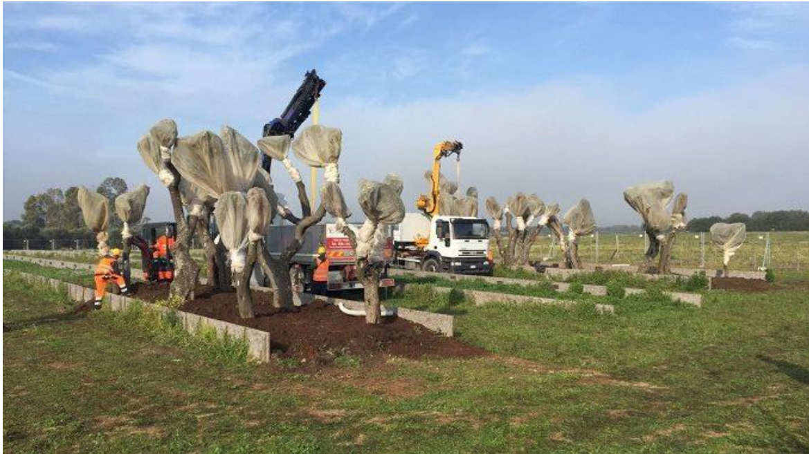
Ulivi espantati dal cantiere TAP e collocati nel sito di conservazione temporanea.
