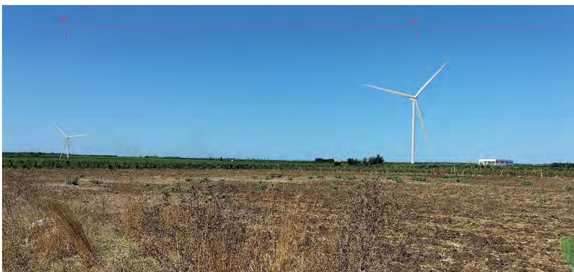
Figura 112 – Stato dei luoghi post operam ID PO25
