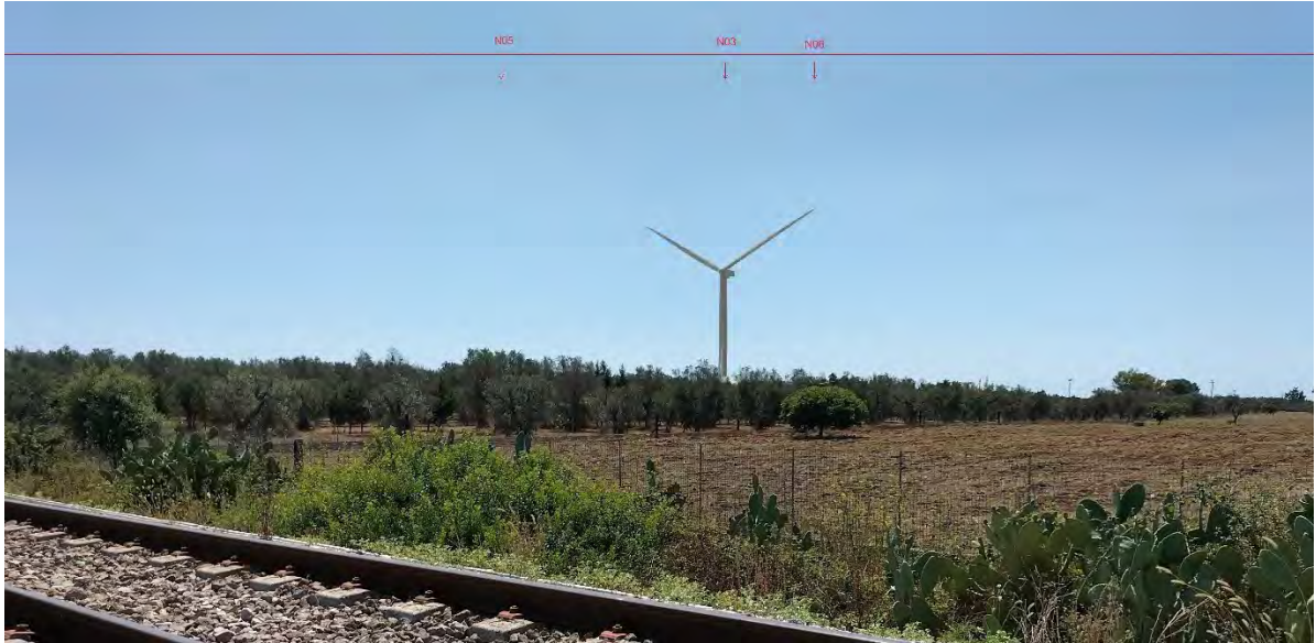
Figura 96 – Stato dei luoghi post operam ID PO14
