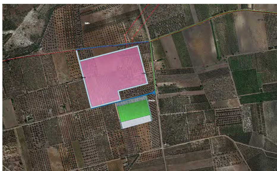
Fig.154 - Stazione satellite in Avetrana
