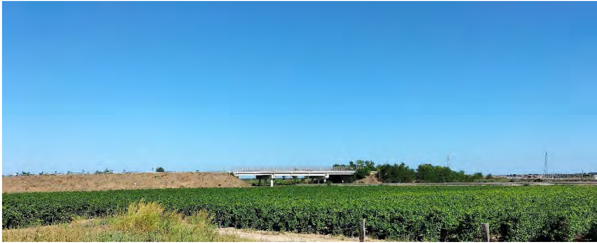
Figura 122 – Stato dei luoghi ex ante operam ID PO66 direzione N01-N02
