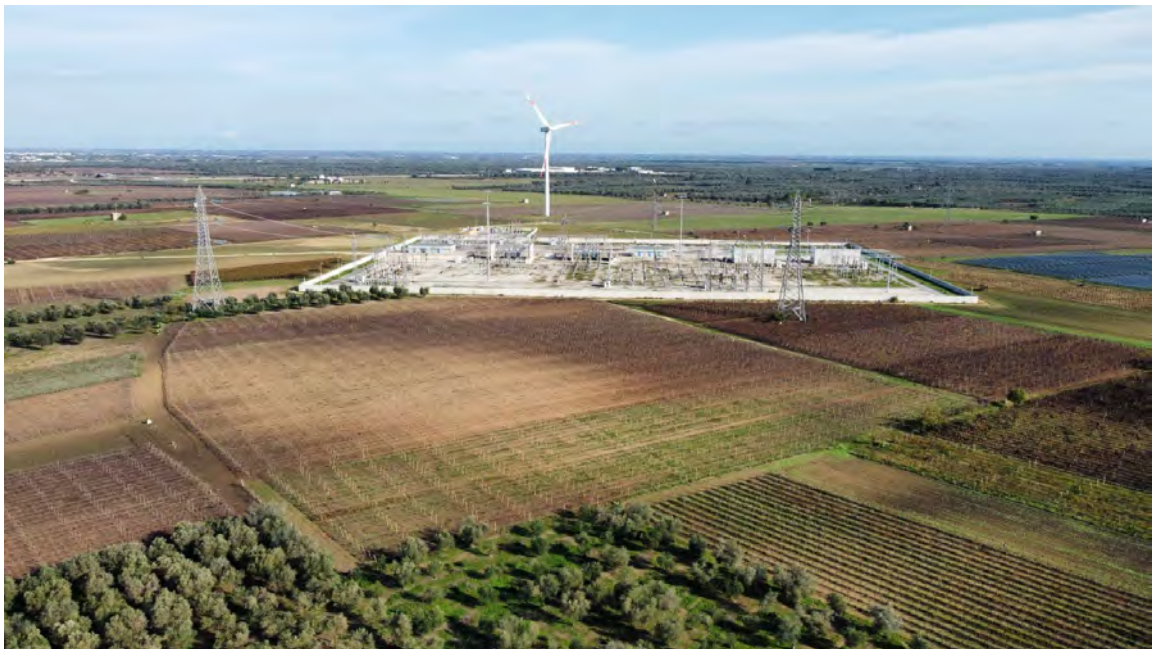
Fig. 28 - Report fotografico - Area SE ERCHIE(BR) esistente - Foto1 indicata su Fig.27 sub21
