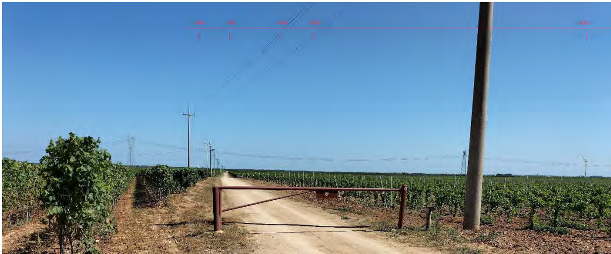
Figura 142 – Stato dei luoghi post operam ID PO43
