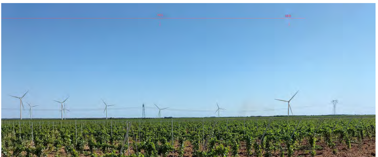
Figura 146 – Stato dei luoghi post operam IDPO43 – cumulativo
