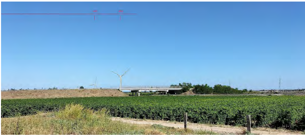
Figura 123 – Stato dei luoghi post operam ID PO66
