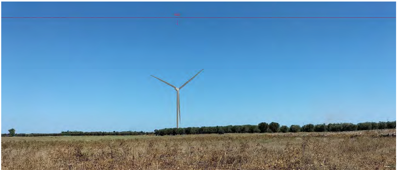
Figura 93 – Stato dei luoghi post operam ID PO14
