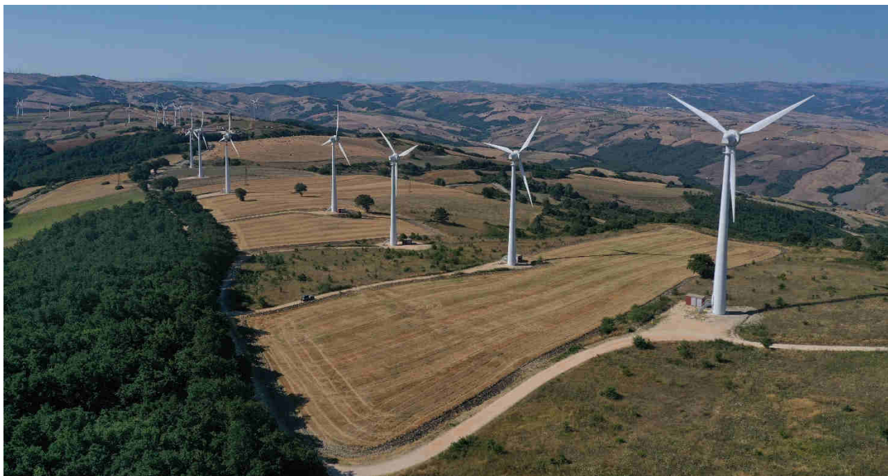
Figura 6. Stato attuale dei luoghi "Impianto B"
