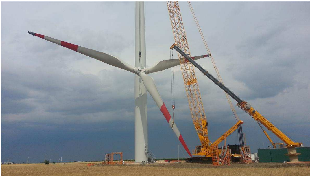
Figura 2. Smontaggio delle pale
