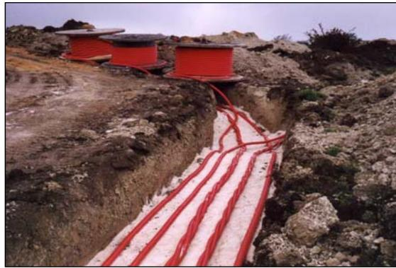
La posa dei cavi sarà effettuata su un letto di sabbia posta sul fondo dello scavo; il rinterro avverrà mediante l'utilizzo di terreno selezionato proveniente dallo scavo.
