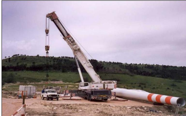
Porzioni di terreno esterne ad essa, che verranno comunque lasciate indisturbate, verranno invece impiegate temporaneamente per la posa a terra e l'assemblaggio delle tre pale al mozzo prima del suo sollevamento in altezza.
