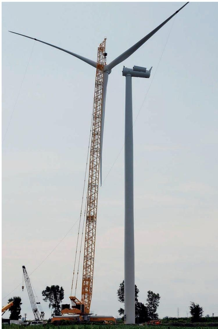
Figura 5.1-1: : Una gru Liebherr 1750 mentre solleva un gruppo rotore per l'installazione
