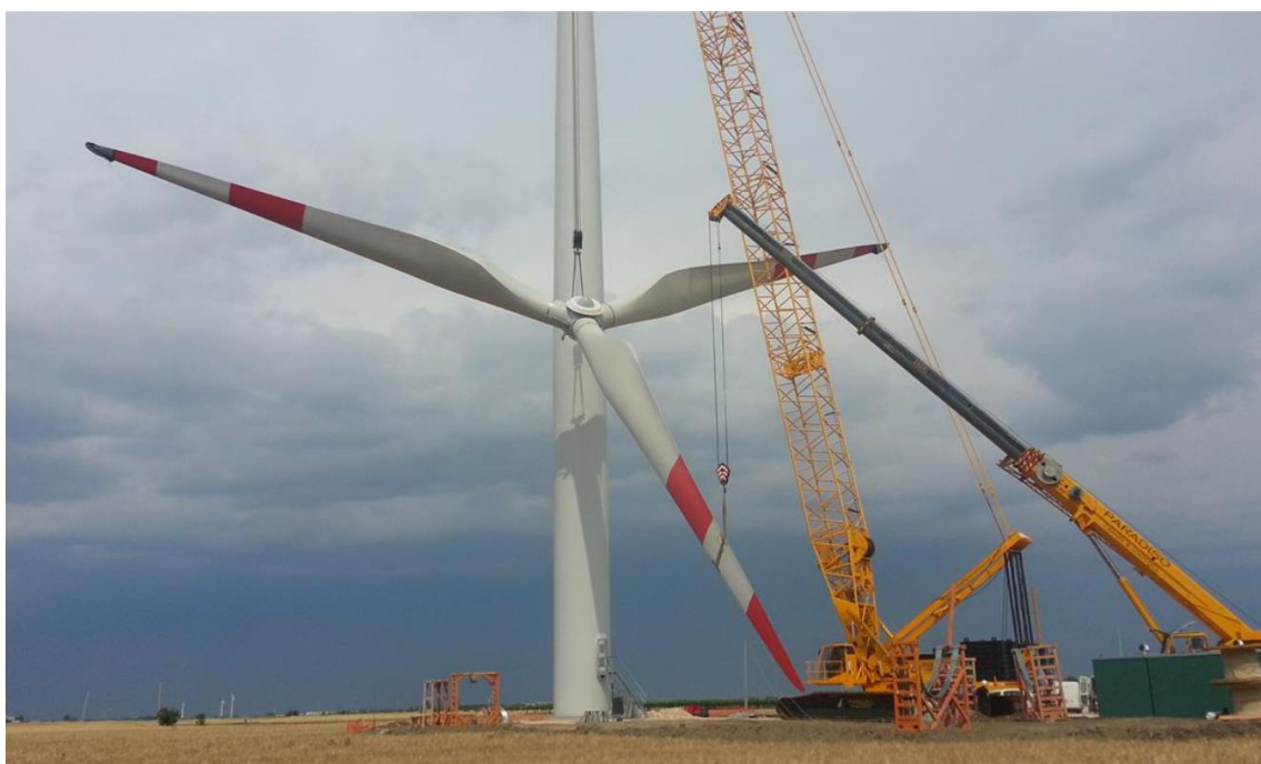
Figura 15 – Montaggio pale
