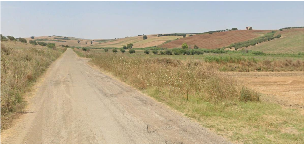
Figura 41 - OB.10 vista stradale
