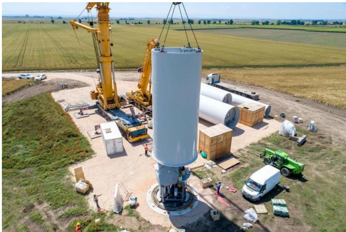
Figura 14 – Montaggio primo tronco della torre
