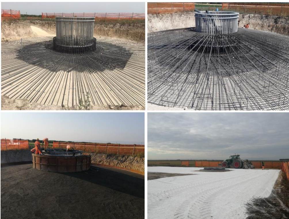
Figura 13 – Principali fasi posa in opera plinto
