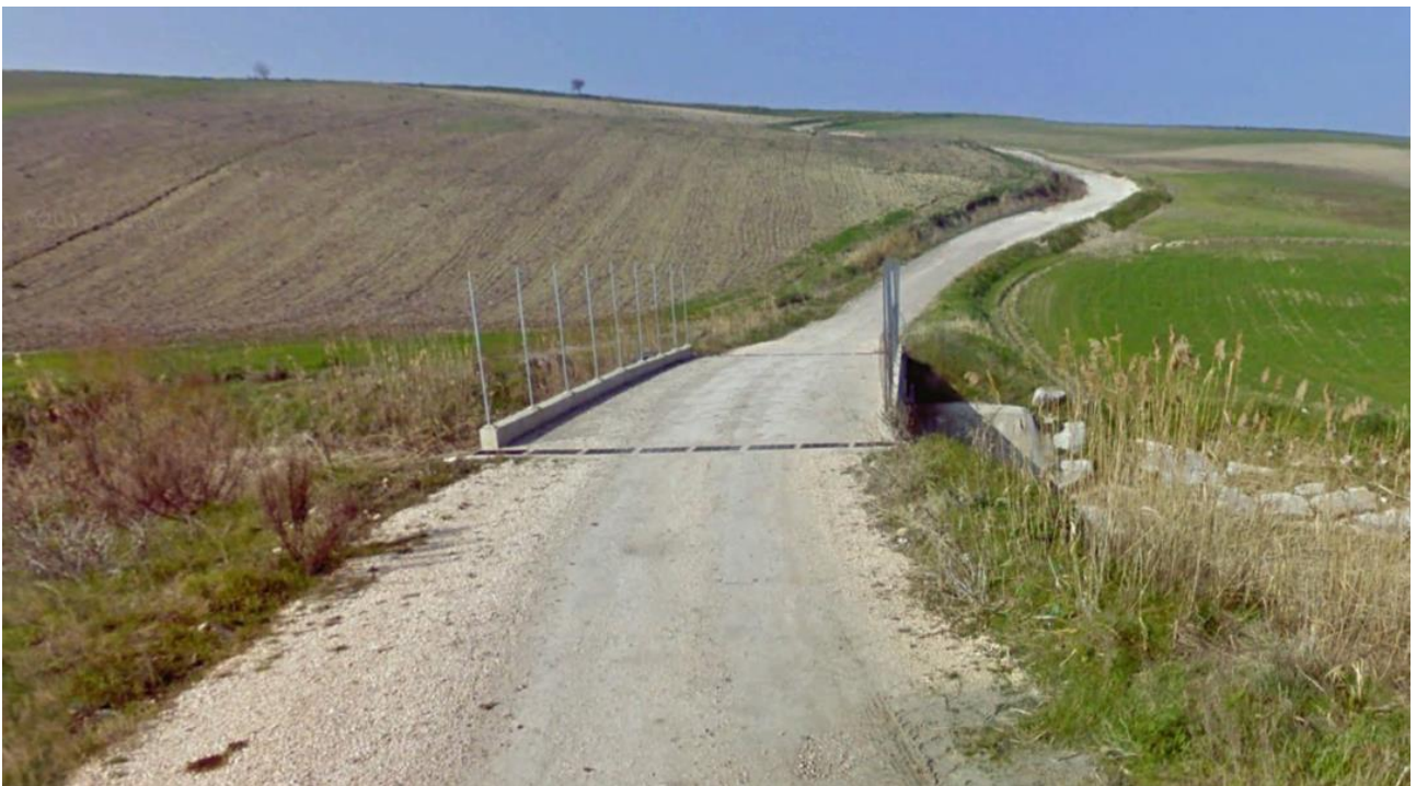
Figura 43 - OB.11 vista stradale
