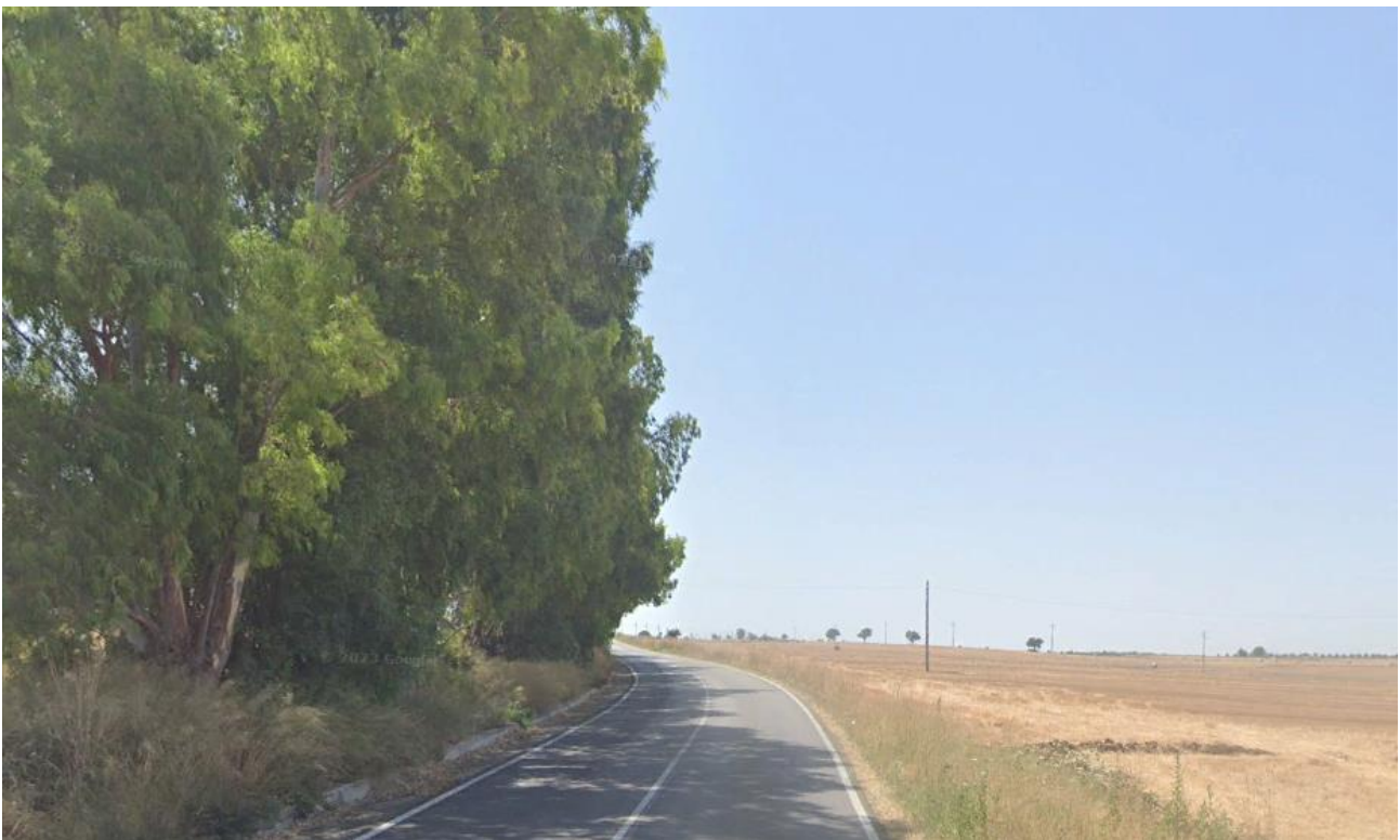
Figura 26 - OB.1 vista stradale
