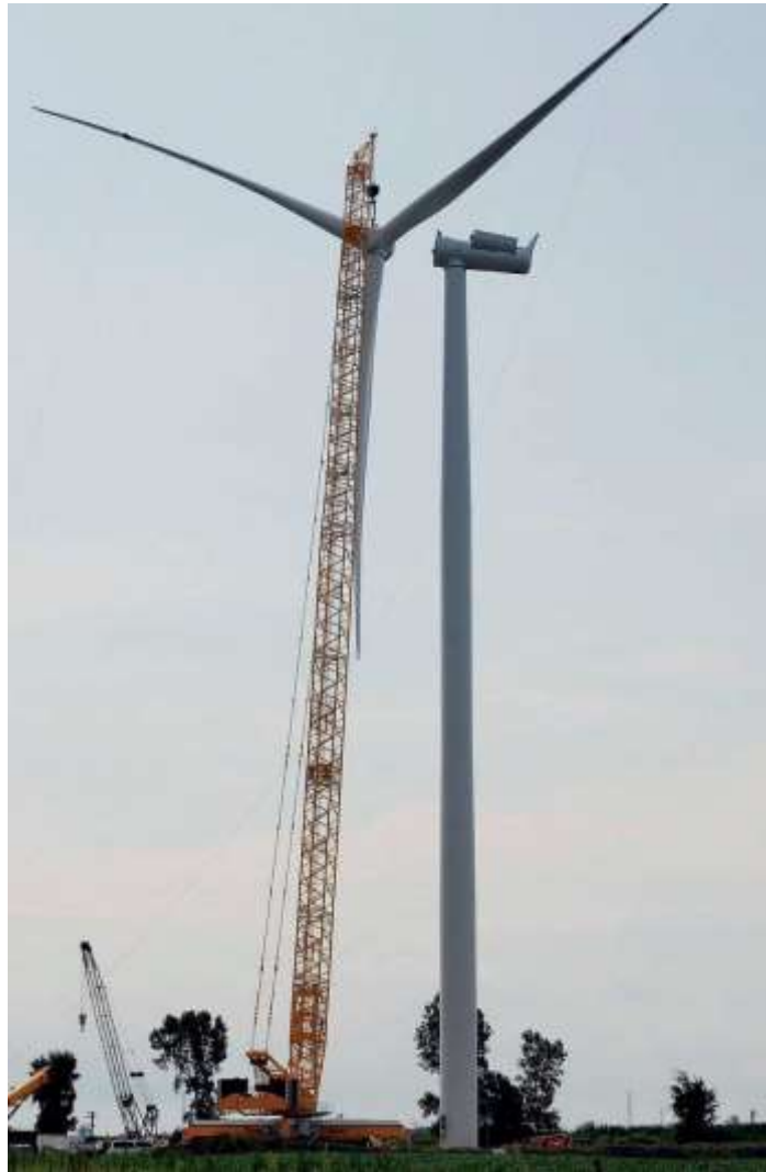
Figura 4-12: Una gru Liebherr 1750 mentre solleva un gruppo rotore per l'installazione
