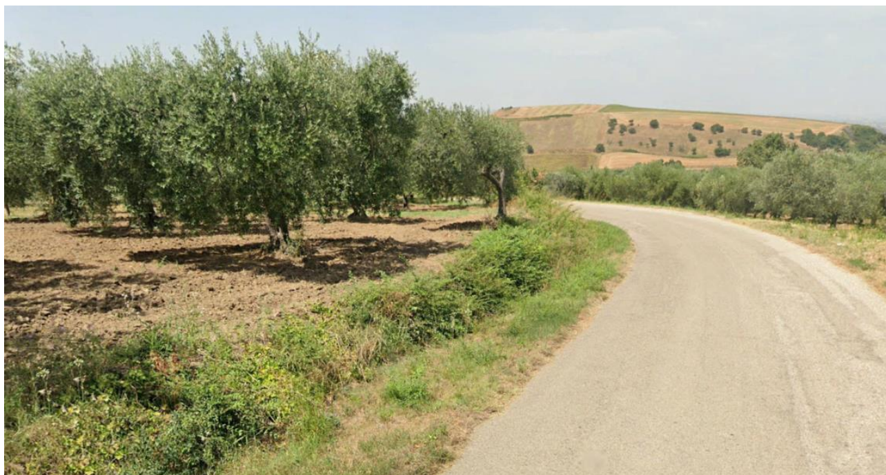
Figura 5-30 – OB.8 vista stradale
