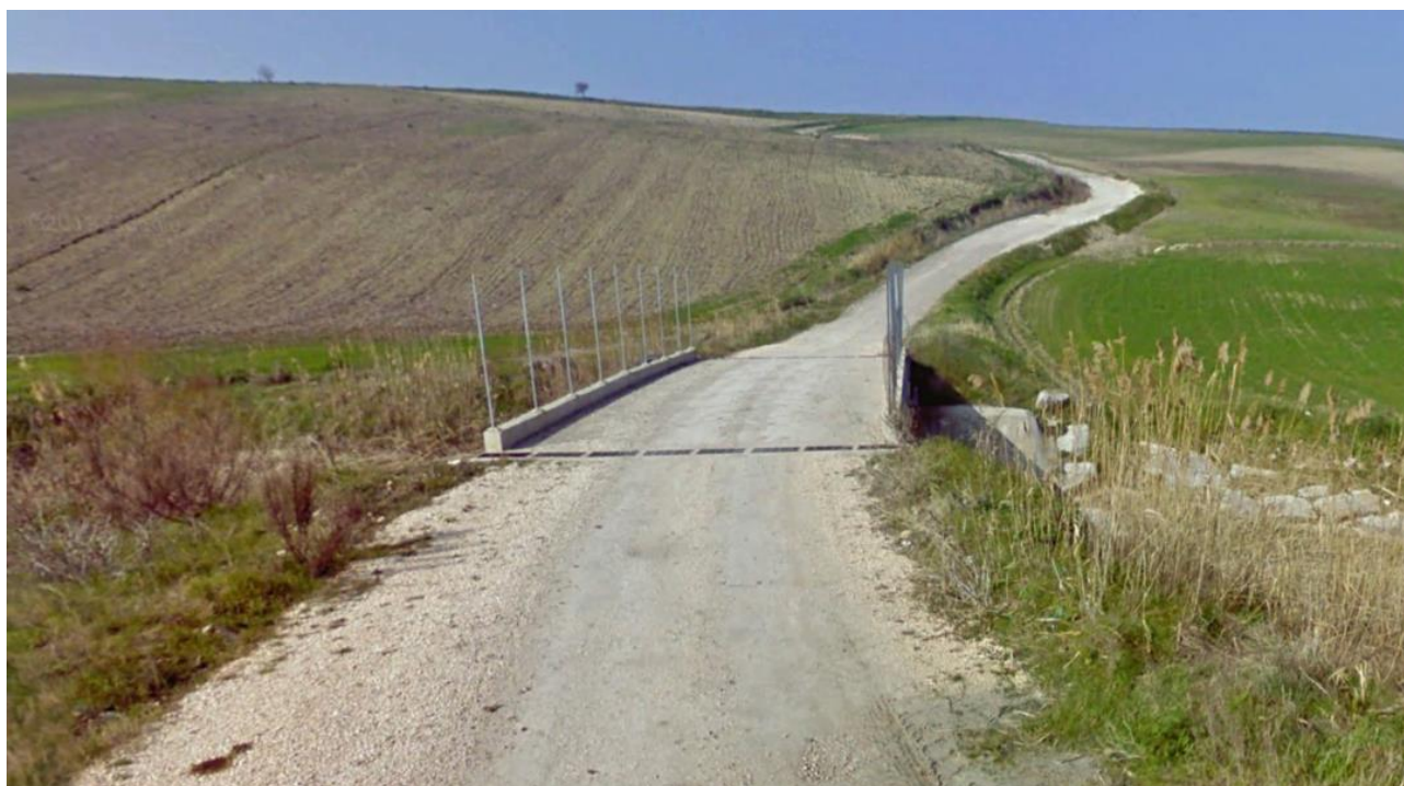
Figura 5-36 - OB.11 vista stradale
