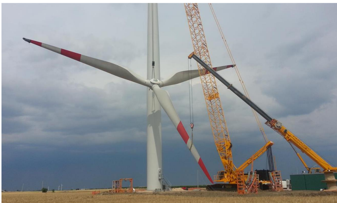
Figura 5-8 – Montaggio pale
