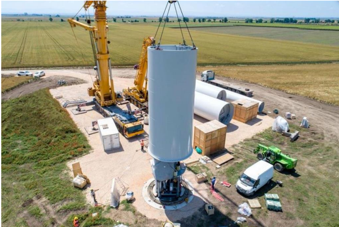
Figura 5-7 – Montaggio primo tronco della torre
