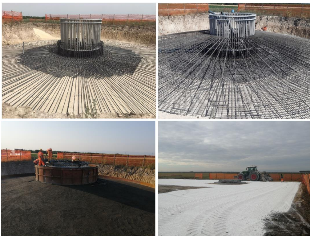
Figura 5-6 – Principali fasi posa in opera plinto
