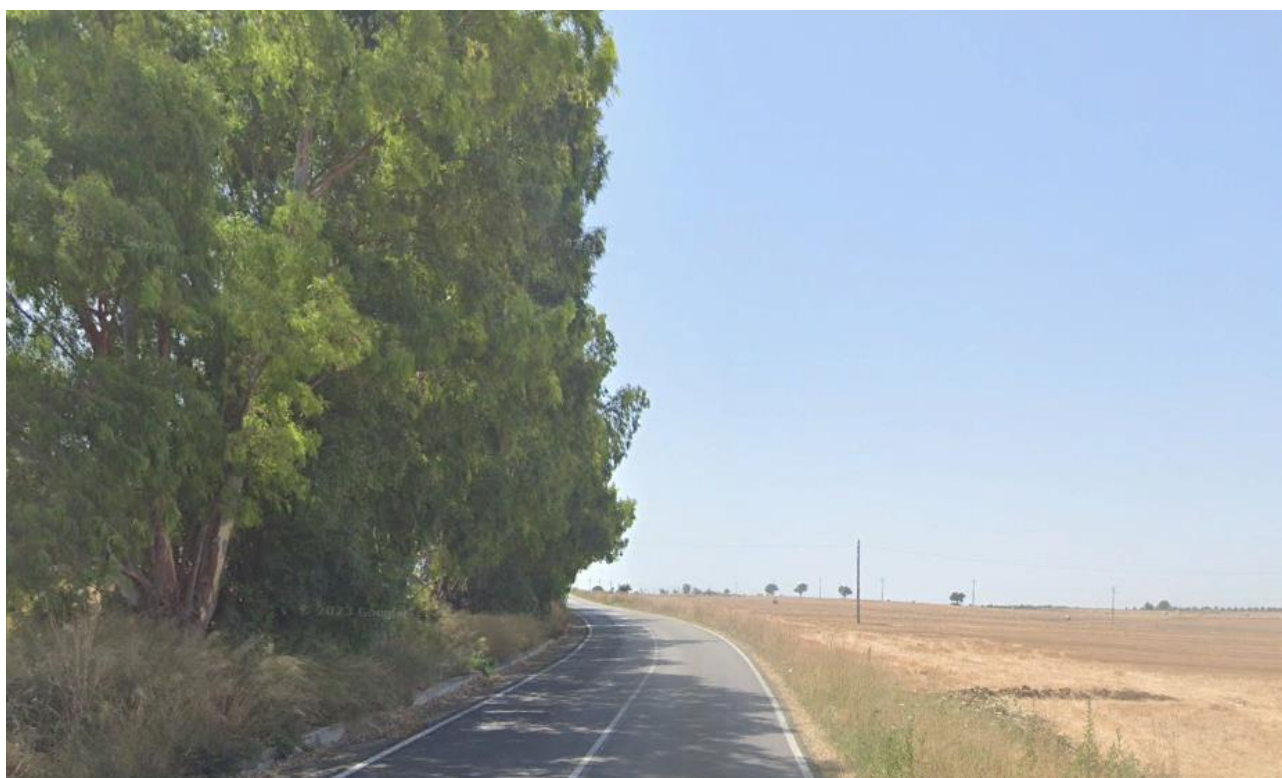
Figura 5-19 - OB.1 vista stradale
