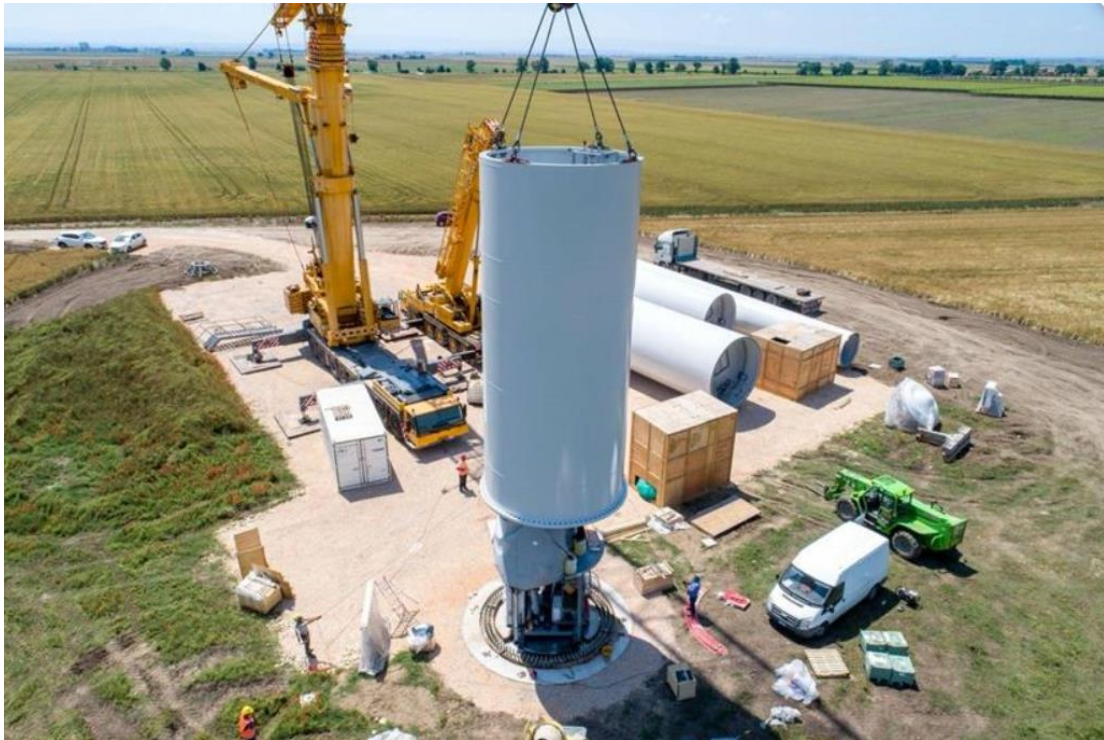
Figura 2—12 – Montaggio primo tronco della torre
