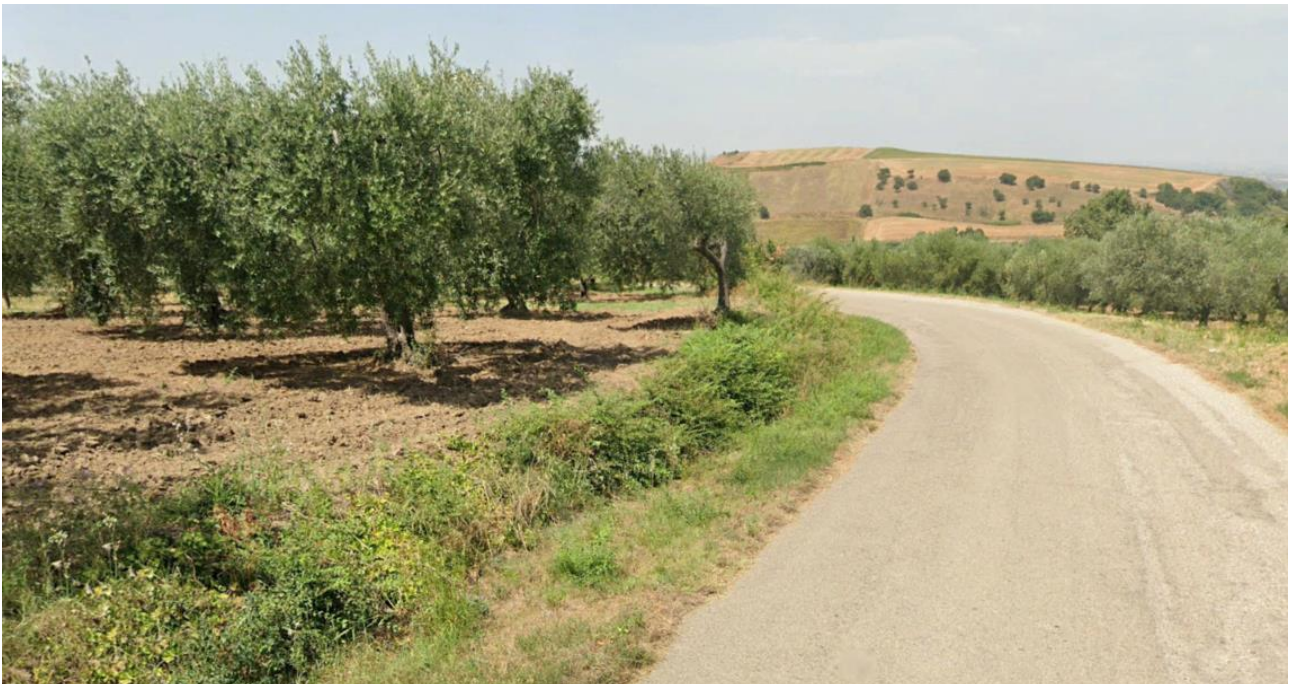
Figura 2—35 – OB.8 vista stradale
