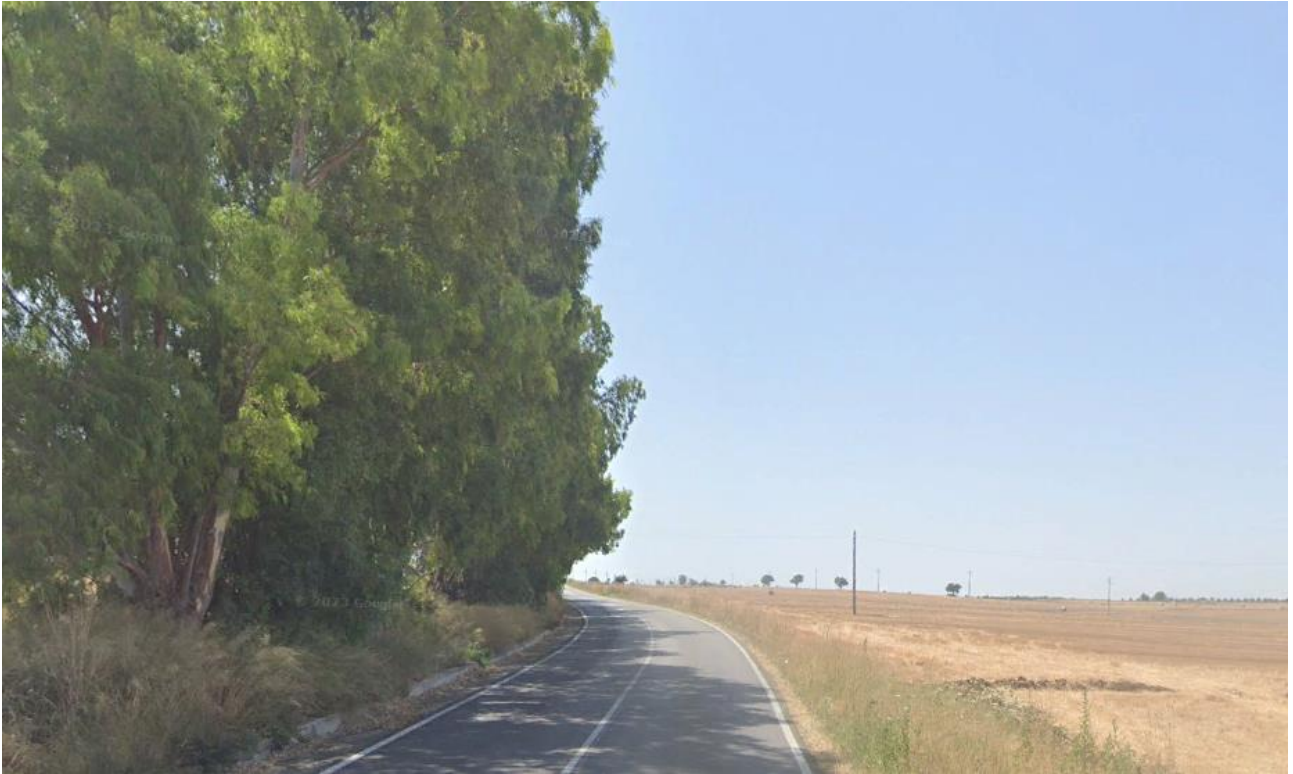
Figura 2—24 - OB.1 vista stradale
