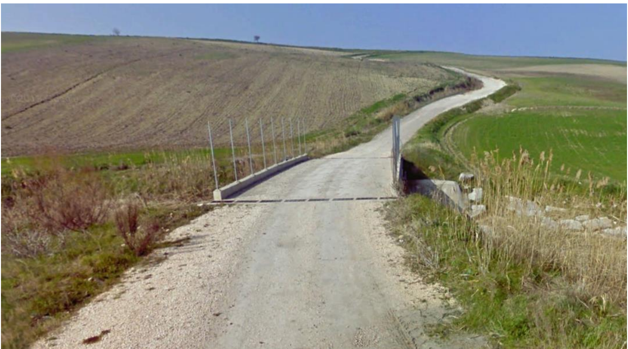
Figura 2—41 - OB.11 vista stradale
