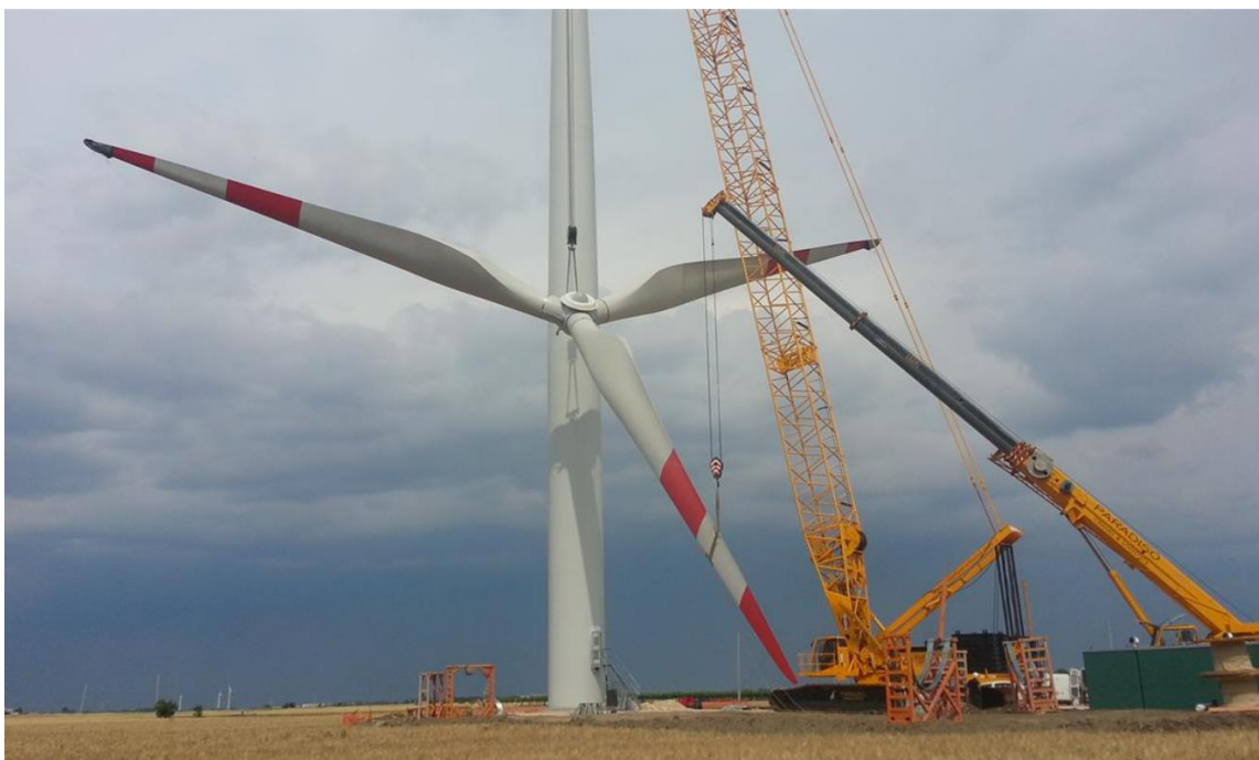
Figura 2—13 – Montaggio pale
