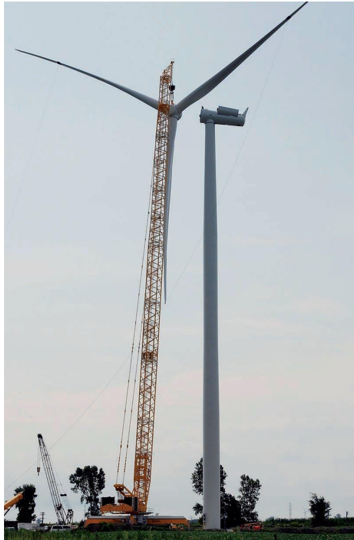
Figura 2—5: Una gru Liebherr 1750 mentre solleva un gruppo rotore per l’installazione
