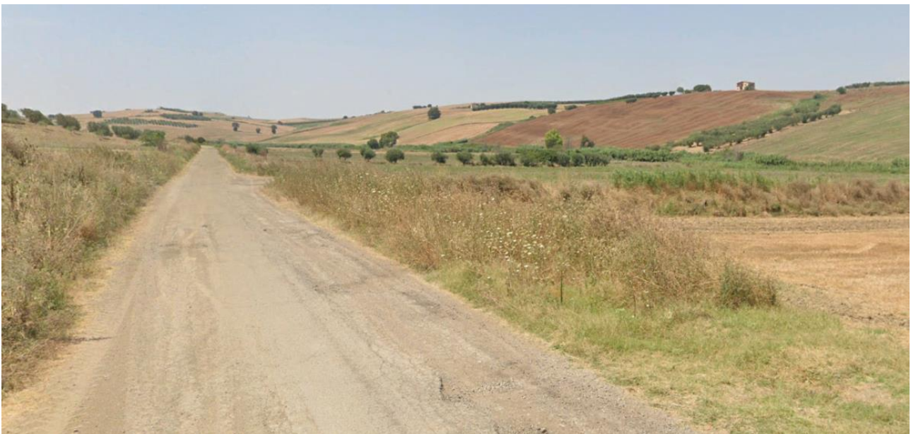
Figura 2—39 - OB.10 vista stradale
