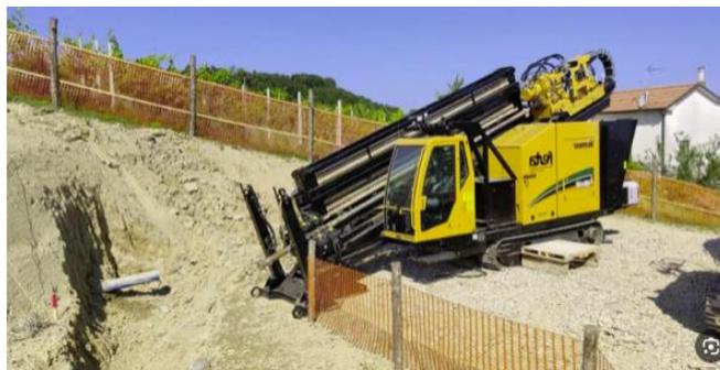
Figura 5 – Macchina operatrice per T.O.C.
