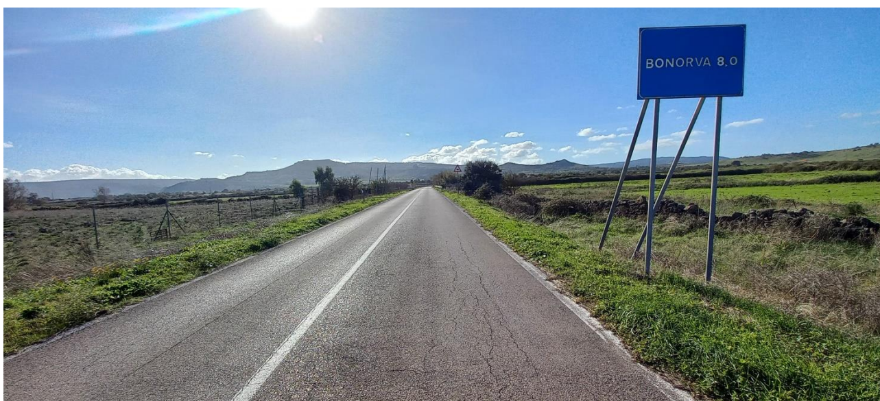
PUNTO FOTO 23. Tracciato cavidotto.
