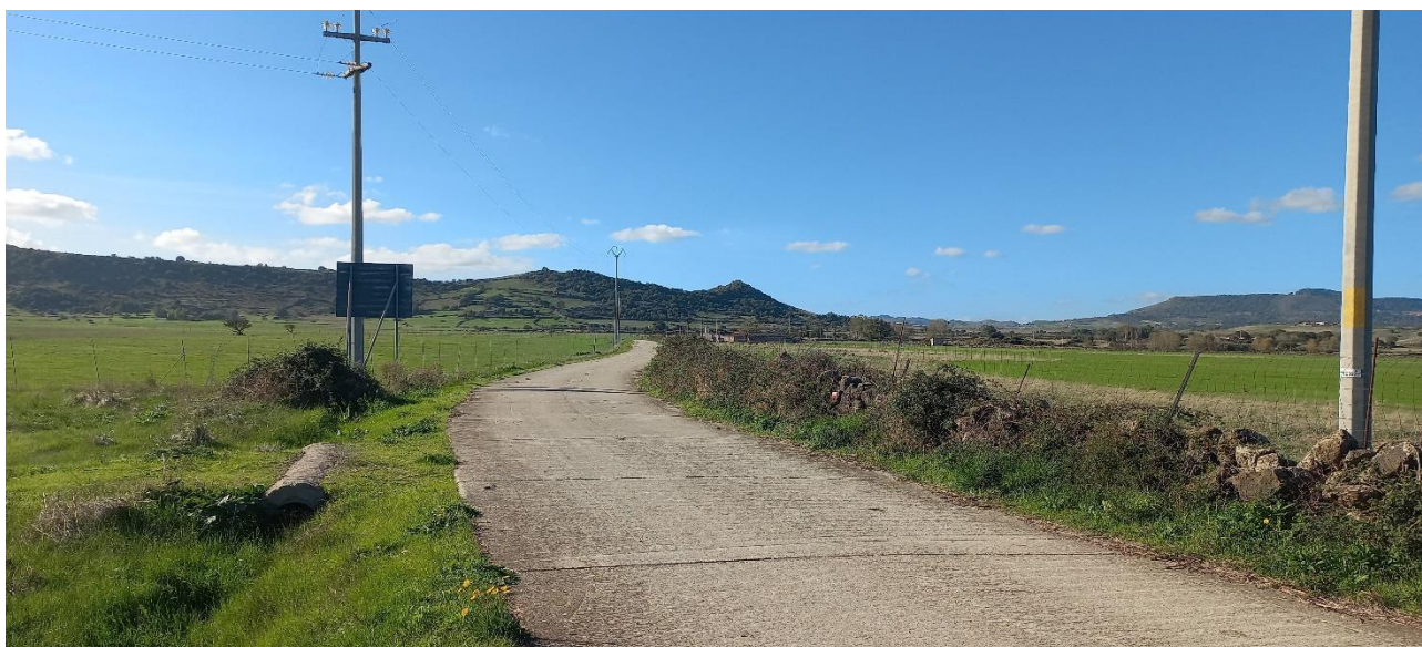
PUNTO FOTO 22. Tracciato cavidotto.
