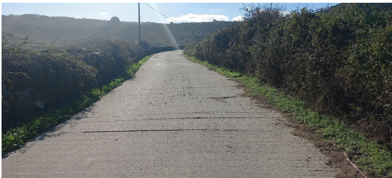
PUNTO FOTO 21. Tracciato cavidotto.
