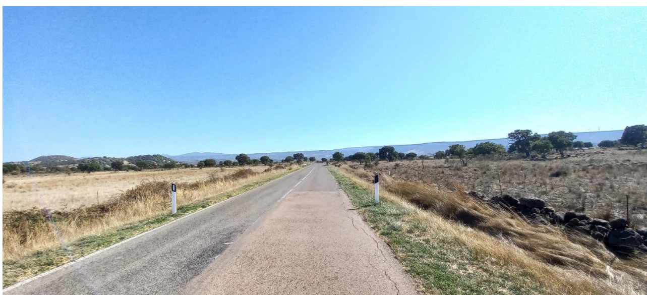
PUNTO FOTO 24. Tracciato cavidotto.
