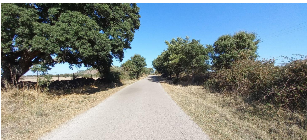
PUNTO FOTO 29. Tracciato cavidotto.
