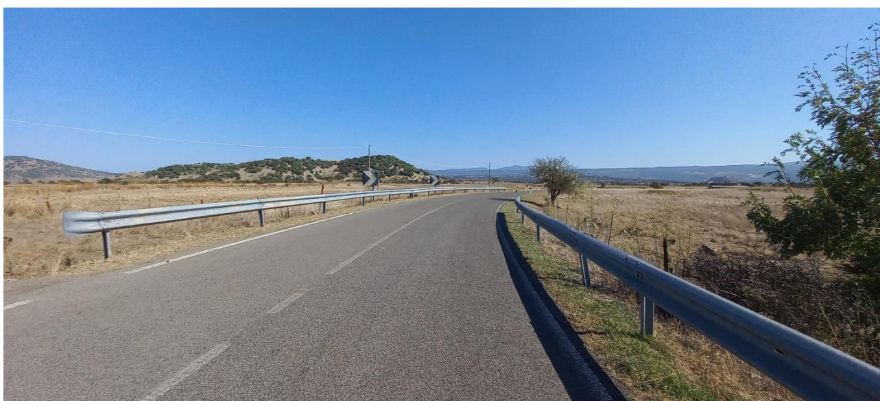
PUNTO FOTO 26. Tracciato cavidotto.
