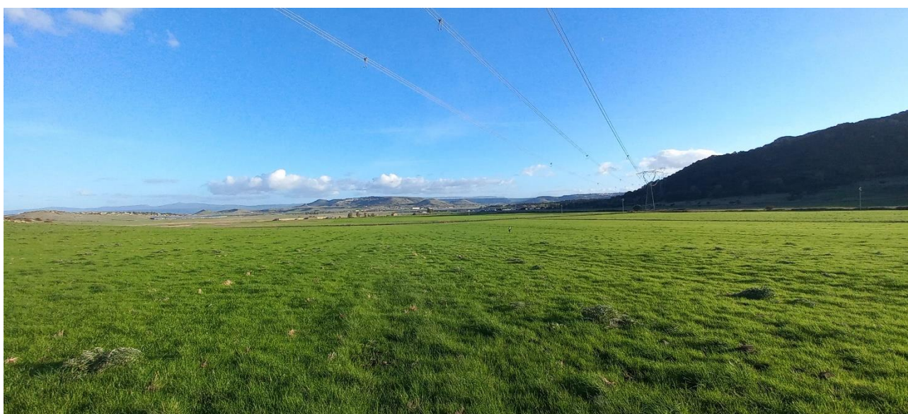
PUNTO FOTO 5. Cheremule. Area impianto agro-fotovoltaico.
