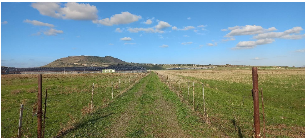
PUNTO FOTO 10. Tracciato cavidotto.
