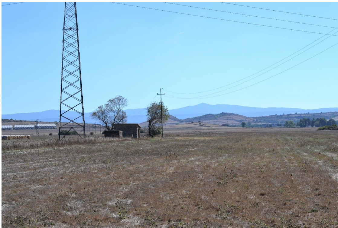
Foto 1 – Linee elettriche in prossimità dell'area di progetto
