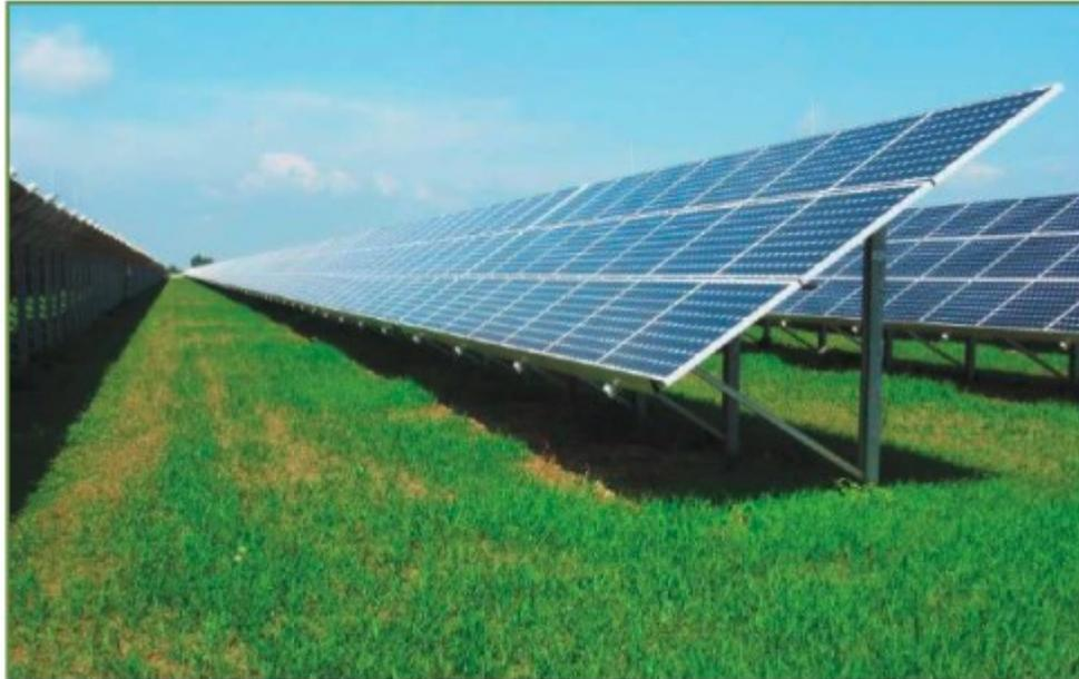
Indicativamente il portale tipico della struttura progettata è costituito da 28 moduli montati con una disposizione su due file in posizione verticale. Tale configurazione potrà variare in conseguenza della scelta del tipo di modulo fotovoltaico.
