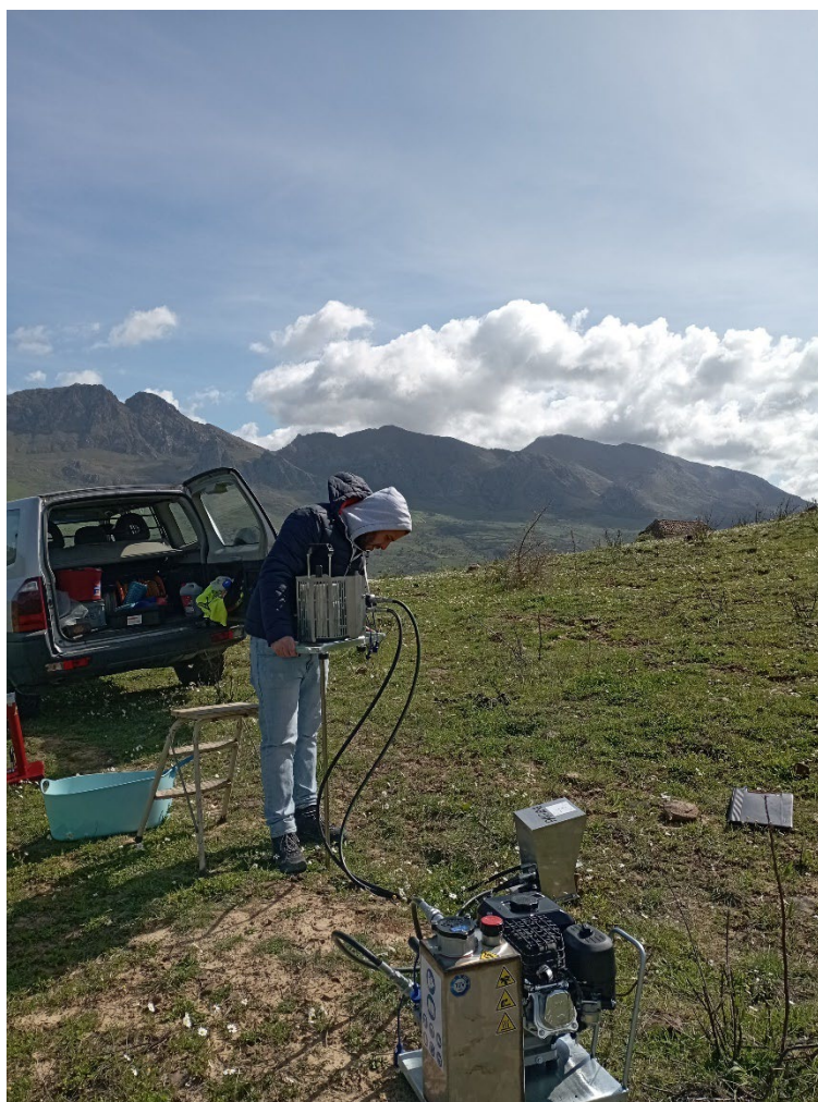
Figura 7 - Fase di approntamento all'esecuzione della prova penetrometrica DP6.
