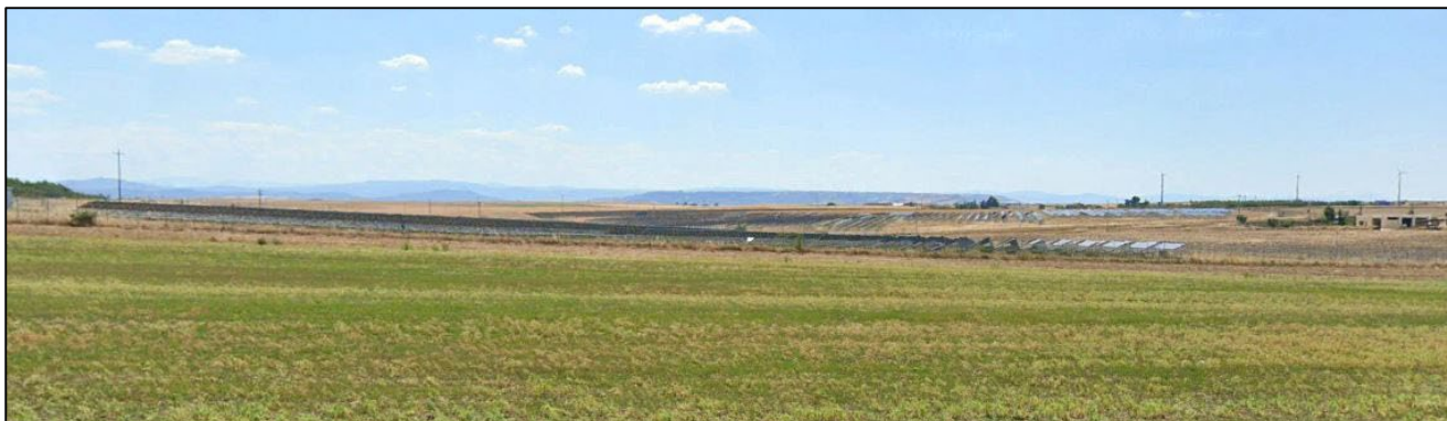
Figura 16-10: Impianti fotovoltaici già realizzati a sud-est dell'area di intervento
