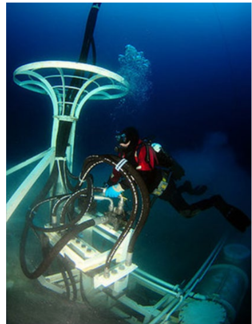
Il trenching chirurgico – esecuzione con aratro a pilotaggio manuale
