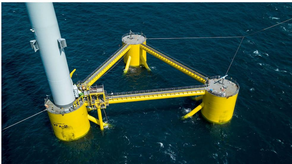
Figura 17: Unità WindFloat T durante il traino. Da <https://www.principlepower.com/windfloat/the-windfloat-advantage>, consultato il 4 dicembre 2023. Per gentile concessione di Principle Power
