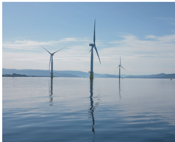
Semisommersibile di Principle Power (a sinistra), Hywind spar (a destra)
