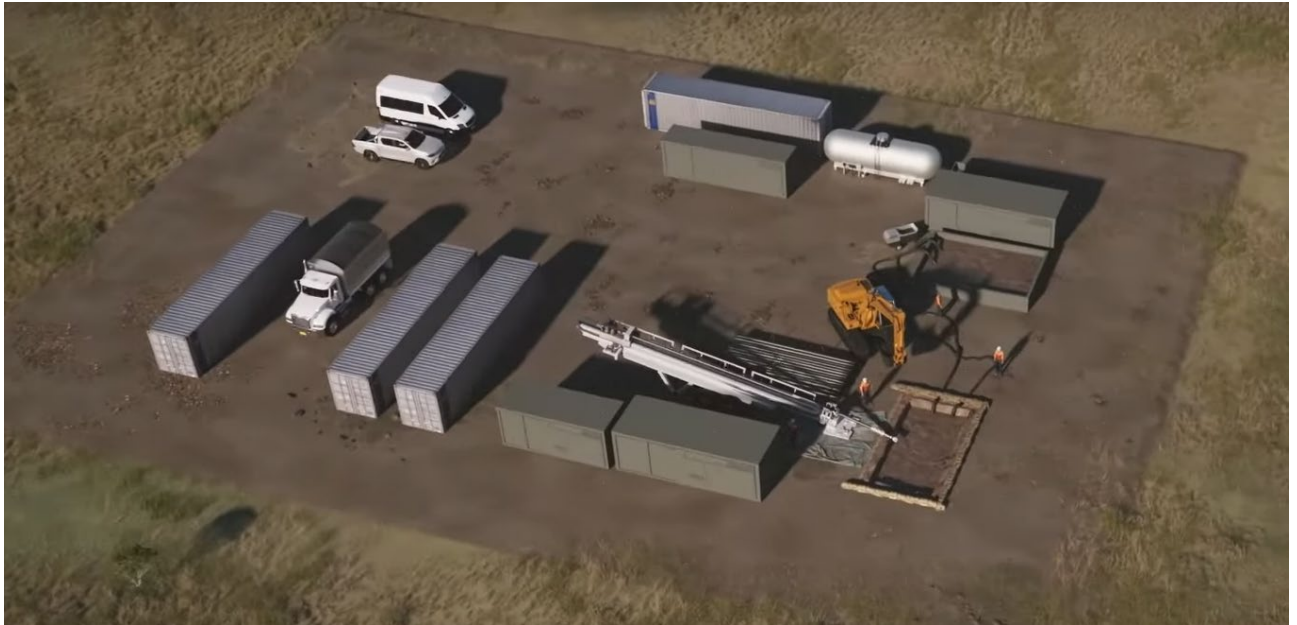
Trivellazione orizzontale controllata, il cantiere base a terra
