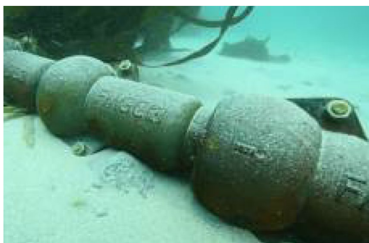
Appoggio e protezione meccanica
