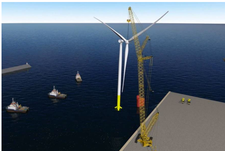
Montaggio di un aerogeneratore in banchina
