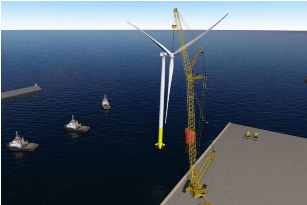
Montaggio di un aerogeneratore in banchina
