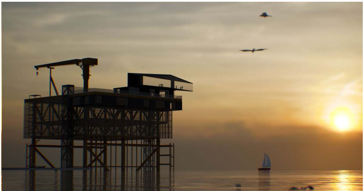
La sottostazione offshore
