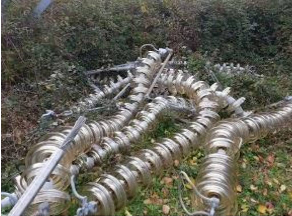
Isolatori smontati dai tralicci sulle colline del Galluzzo.
