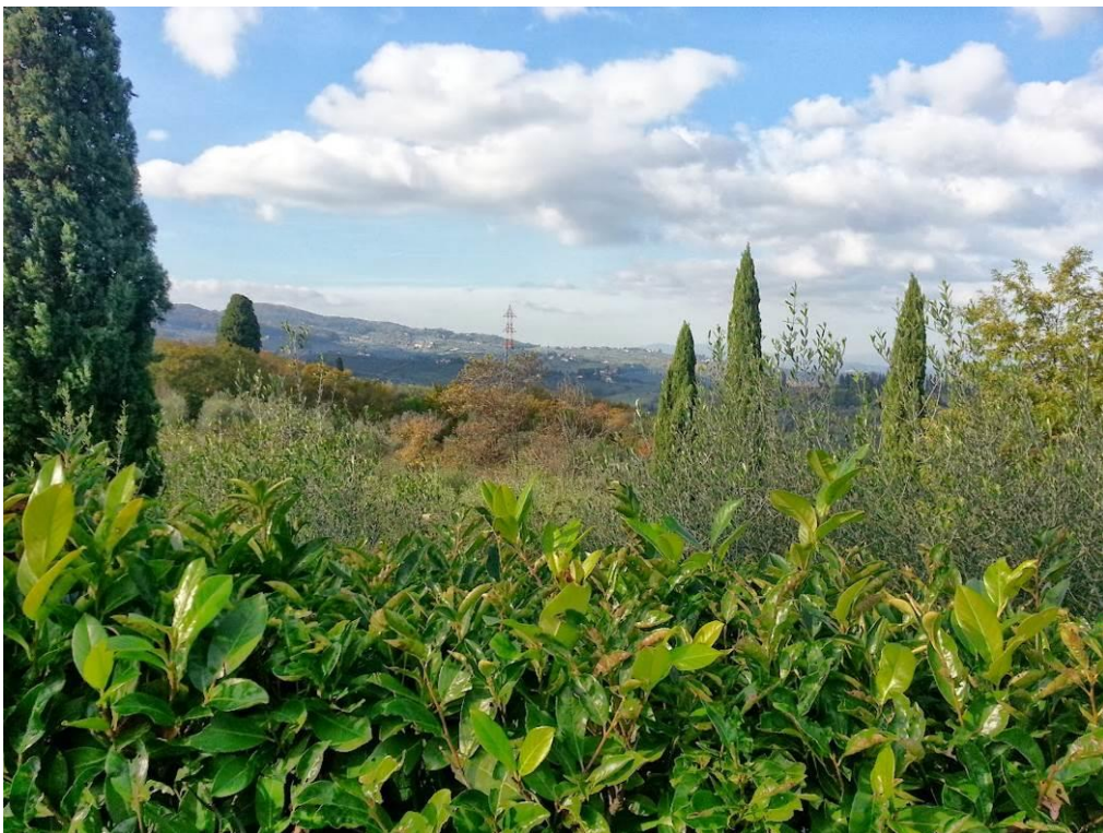
Colline di Firenze con tralicci h 54 m – 380 kV.
