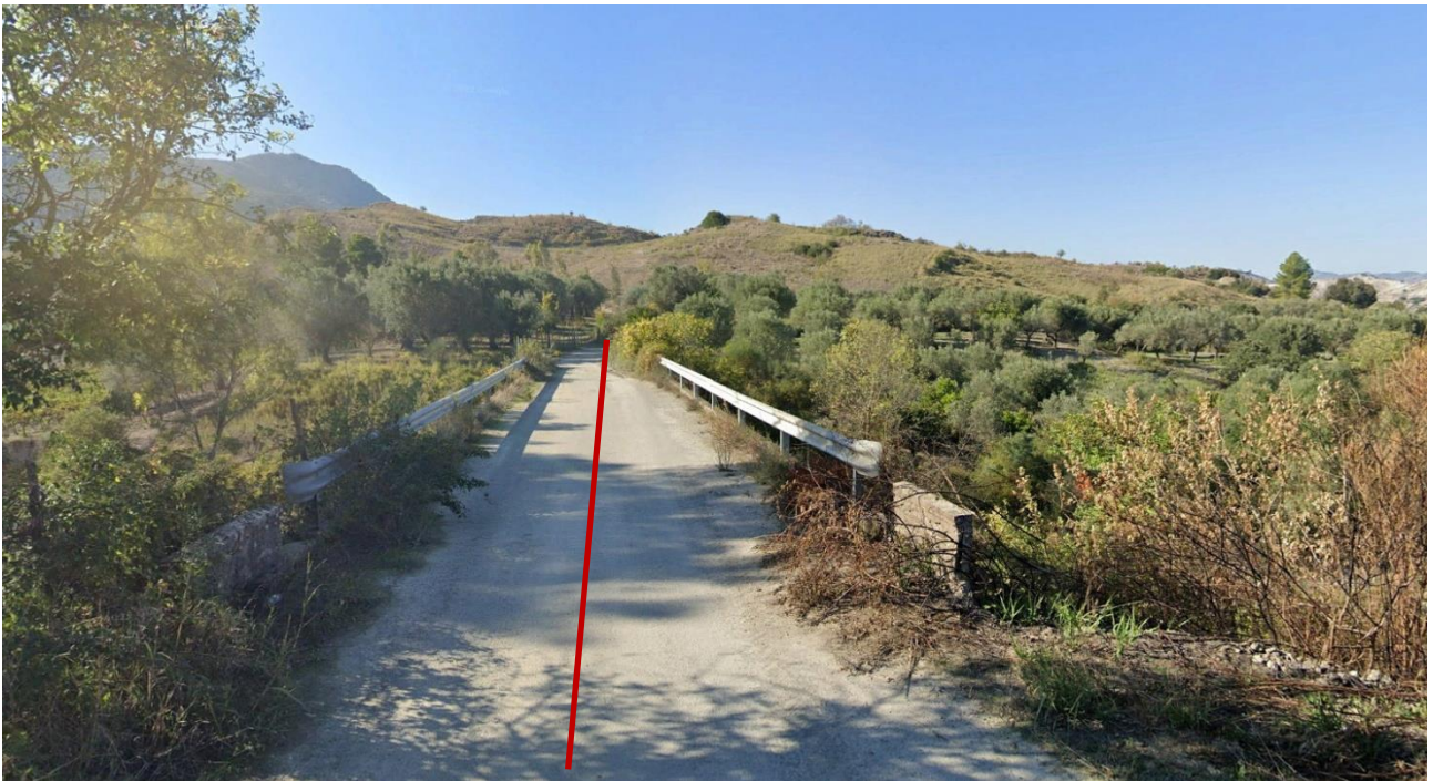
Figura 7-29 - Attraversamento cavidotto (in rosso) su torrente Paita lungo la SP6
