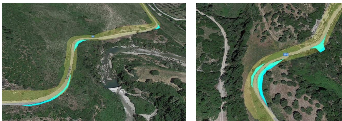
Figura 2-18 Interventi da 5 a 9
