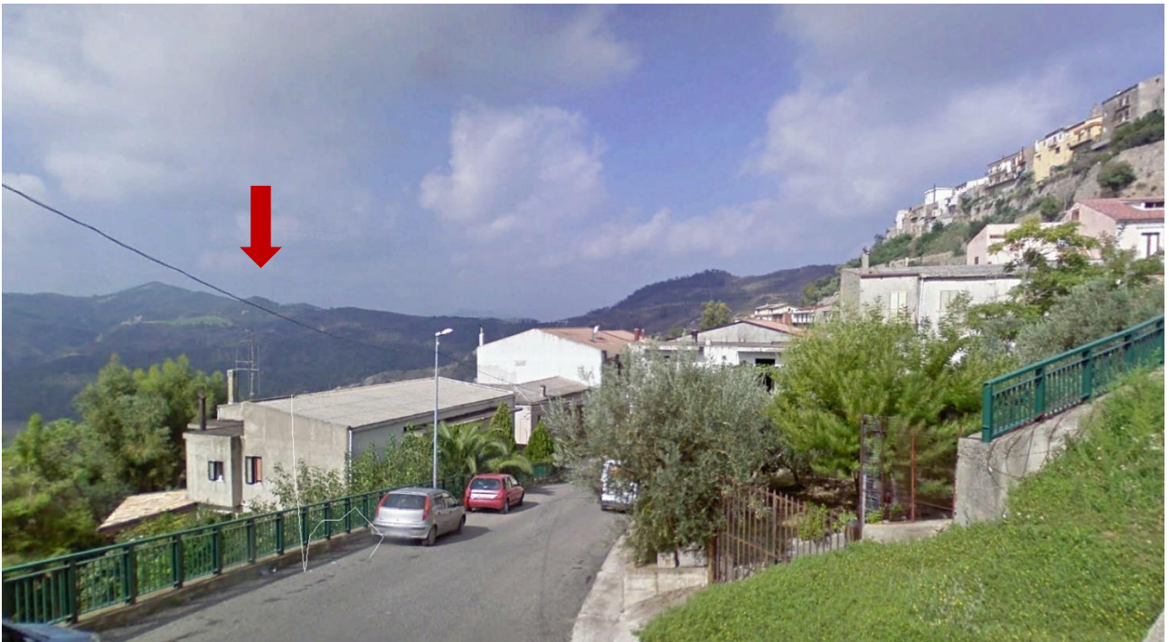
Figura 6-26 - PV09 - Vista da Via A.de Gasperi in località Cirò - La freccia indica la localizzazione del progetto - Distanza punto di visuale da URB14 (aerogeneratore prossimo al PV09): 6,1 Km circa
