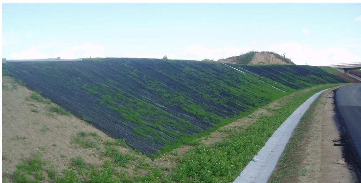
Figura 27 - Esempi di applicazioni di geostuoie
