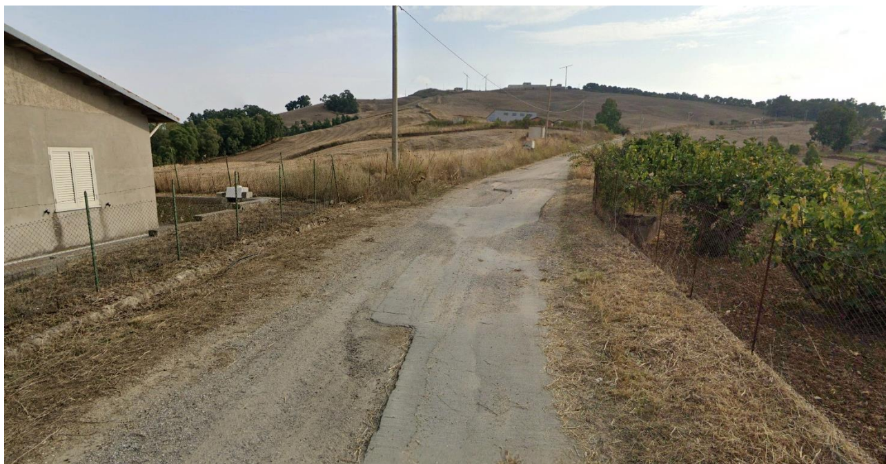
Figura 23 – Viabilità di collegamento con la WTG 6
