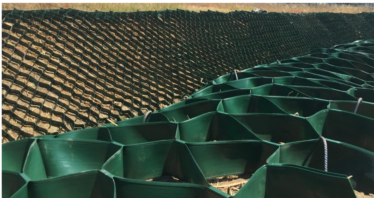
Figura 29 - Esempio di applicazioni con geocelle
