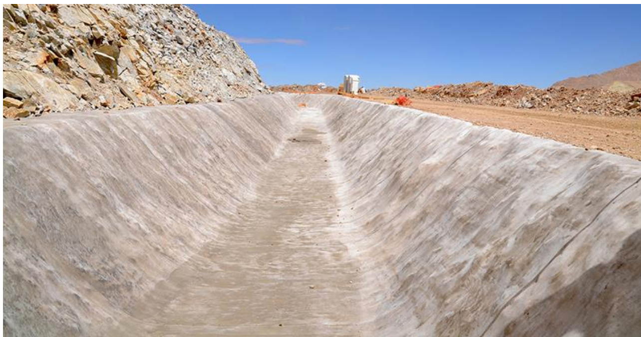
Figura 30 - Esempio di fossa di guardia in terra
