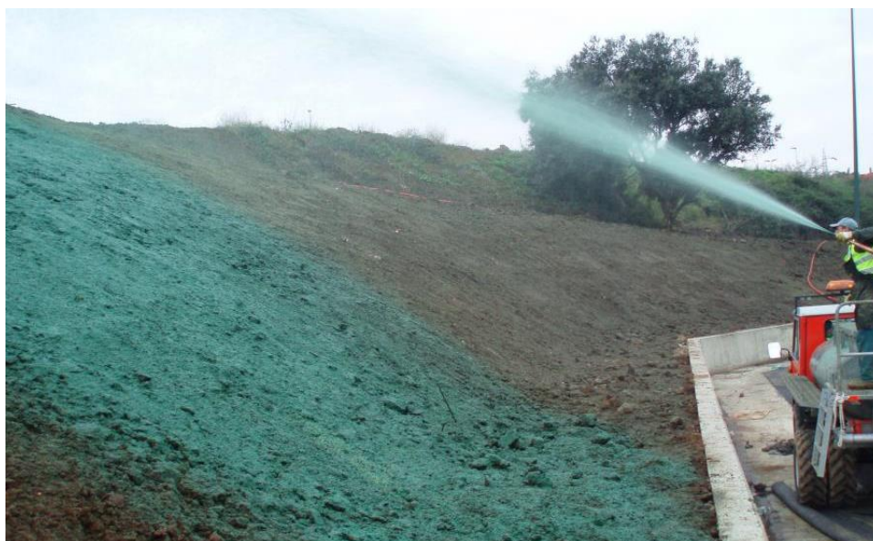
Figura 26 - Esempi di applicazioni di idrosemina
