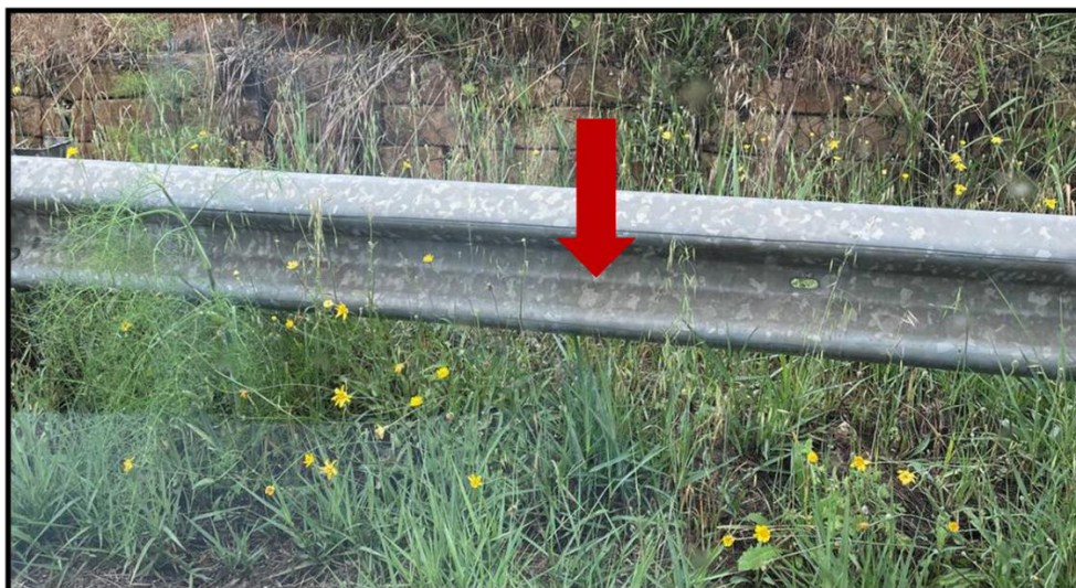
Figura 39 - foto dell'impluvio costituente l'interferenza "Int.72"
