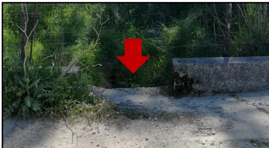
Figura 14 - foto dell'impluvio costituente l'interferenza “Int.23”
