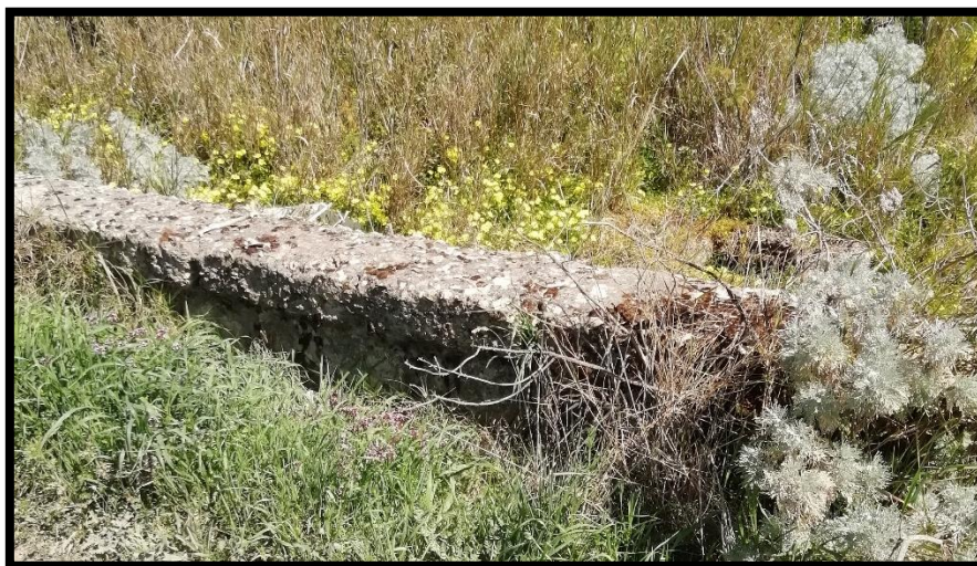
Figura 21 - foto dell'impluvio costituente l'interferenza “Int.30”
