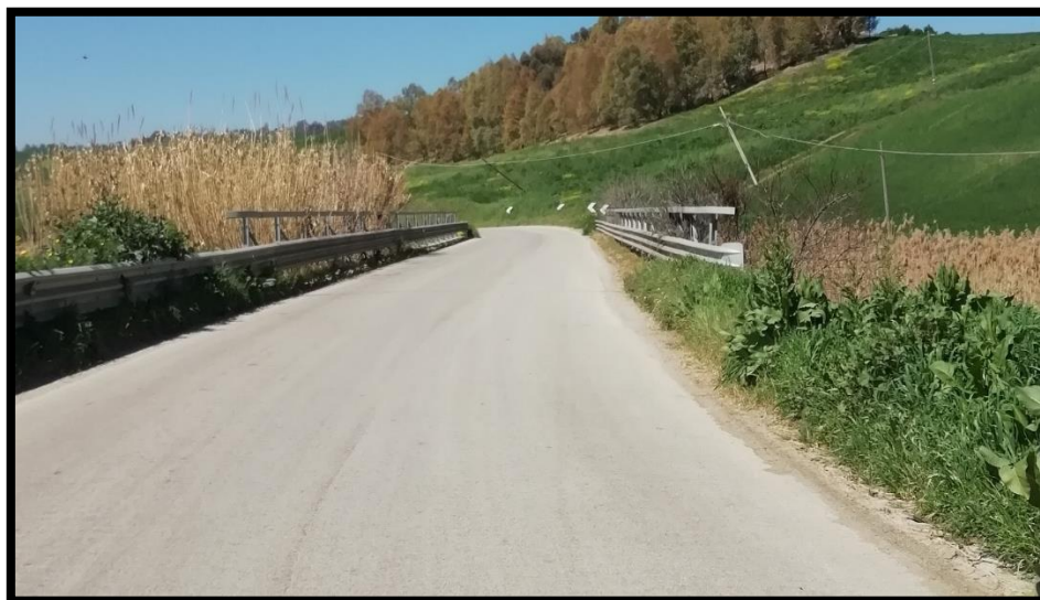
Figura 47 - foto dell'impluvio costituente l'interferenza “Int.15”
