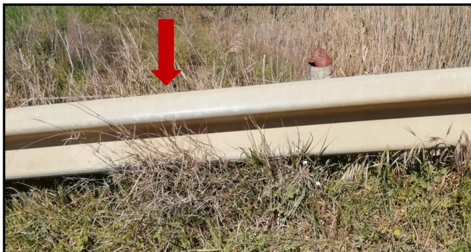
Figura 23 - foto dell'impluvio costituente l'interferenza “Int.32”
