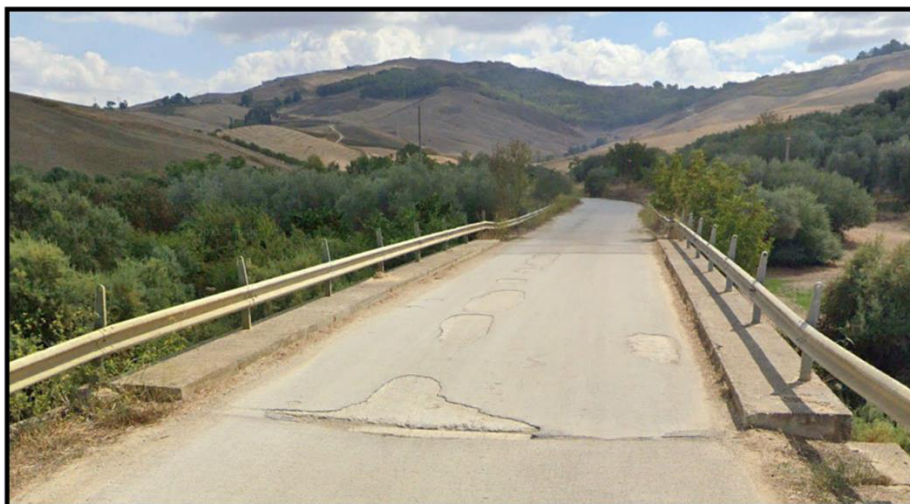
Figura 48 - foto dell'impluvio costituente l'interferenza "Int.16"
