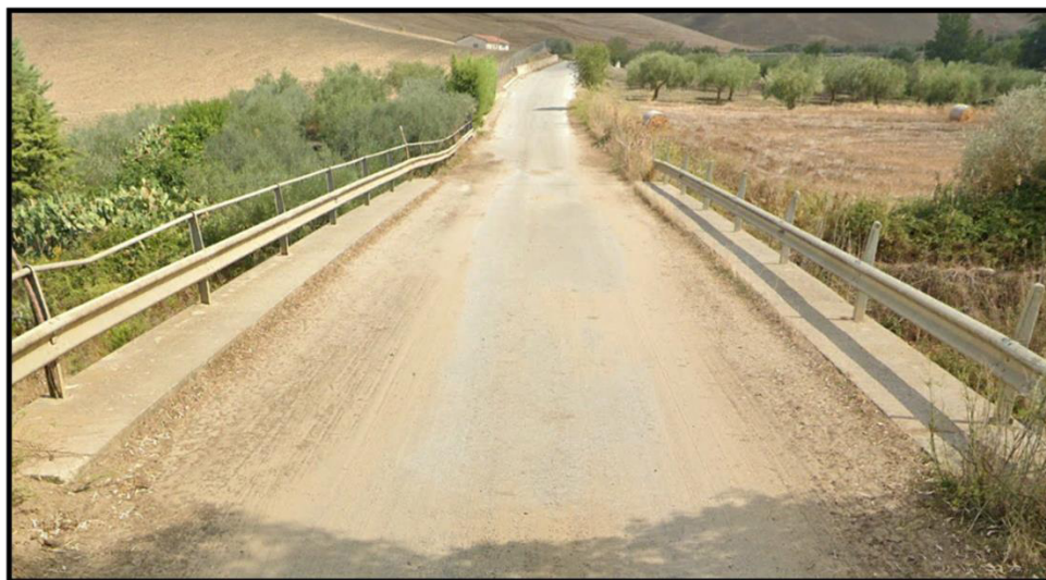
Figura 49 - foto dell'impluvio costituente l'interferenza "Int.17"
