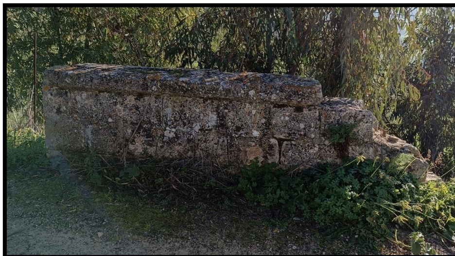
Figura 17 - foto dell'impluvio costituente l'interferenza “Int.26”
