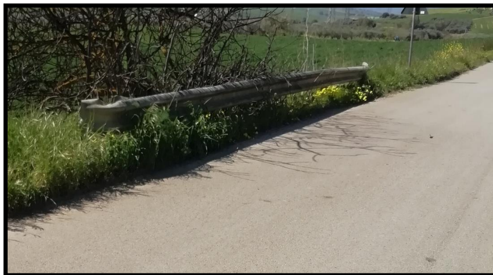
Figura 25 - foto dell'impluvio costituente l'interferenza “Int.34”
