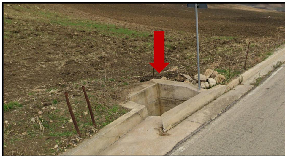
Figura 36 - foto dell'impluvio costituente l'interferenza "Int.47"
