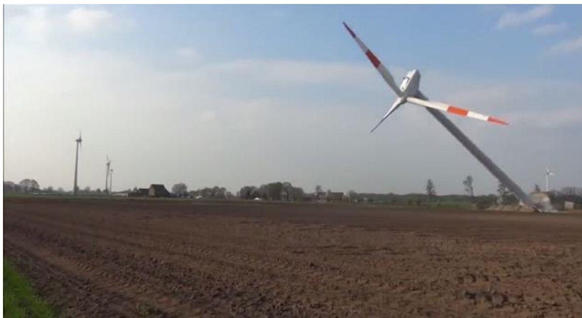
Figura 9- Ribaltamento della torre alla radice
