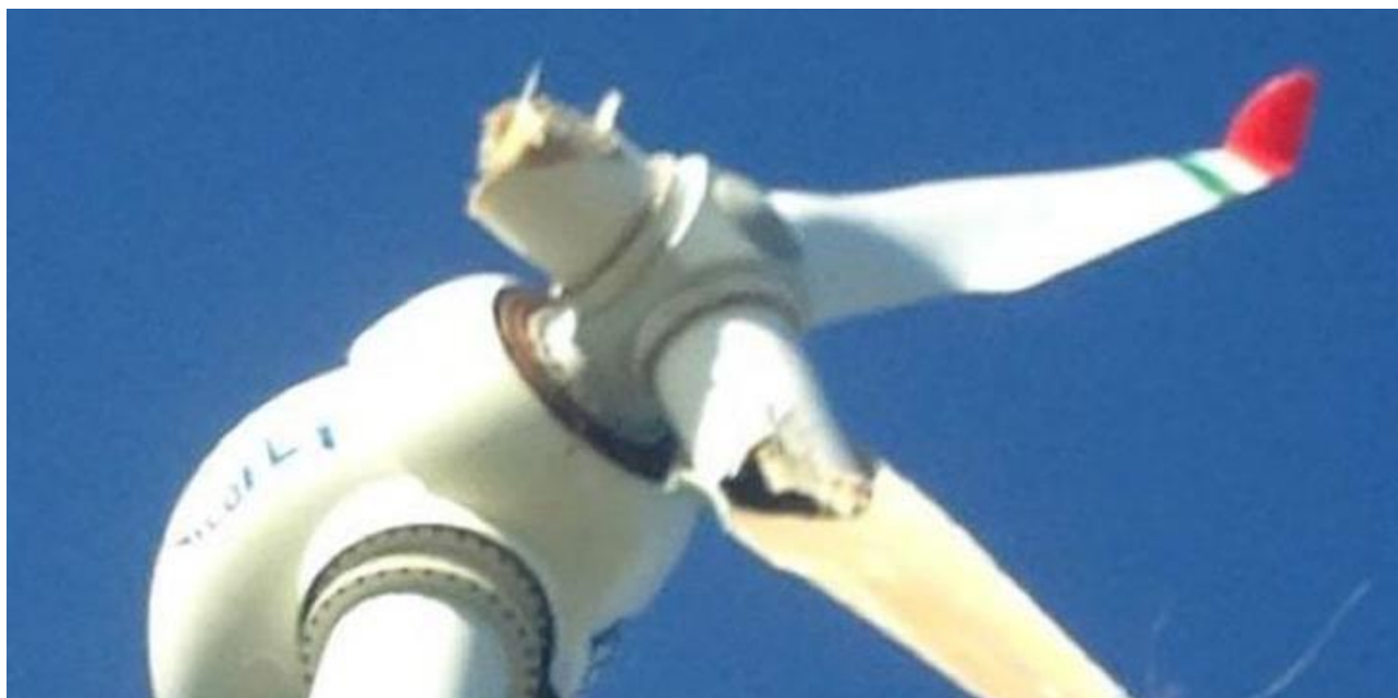
Figura 5- Esempio di rottura alla radice
