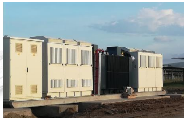
Figura 15 esempio di stazioni di Potenza MT a servizio dello storage
