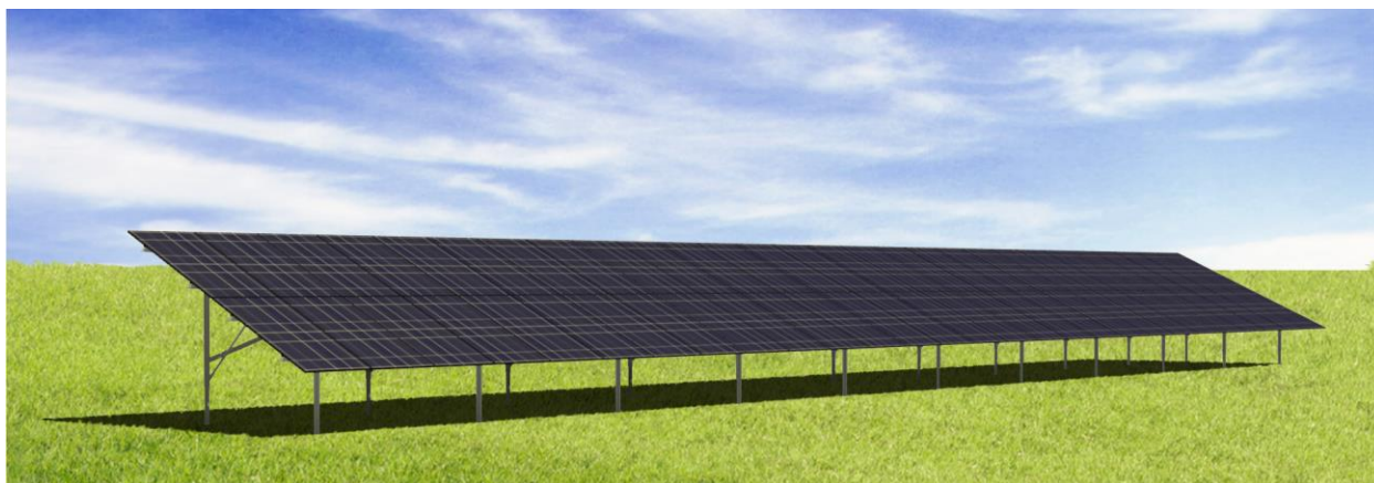
Figura 6.2 Tipologia di struttura di sostegno moduli fissa
