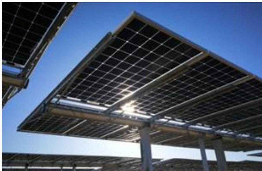
Figura 3.4: Esempio di struttura a tracker monoassiale 2p.
