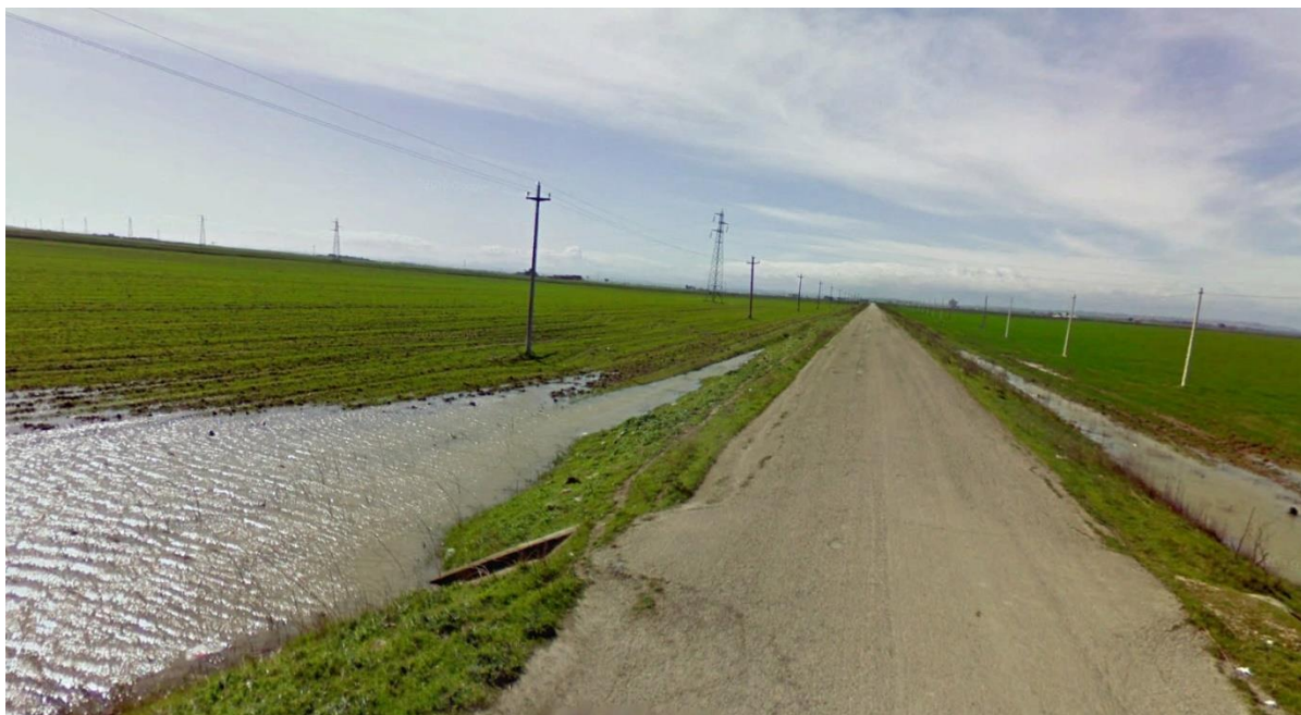
Figura 5.23: Immagine dell'interferenza della connessione con il fosso di scolo.
