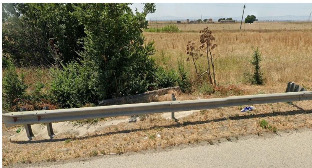
Figura 5.10: Immagine dell'interferenza della connessione con l'elemento idrico, vista verso valle.
