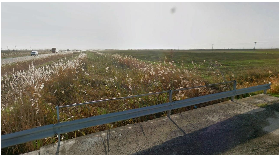
Figura 5.15: Immagine dell'interferenza della connessione con l'elemento idrico, vista verso valle.
