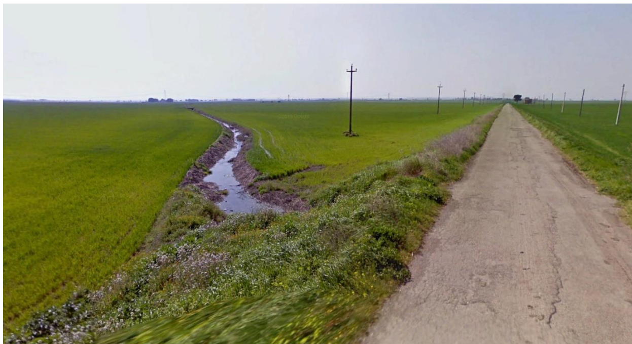
Figura 5.34: Immagine dell'interferenza della connessione con l'elemento idrico, vista verso valle.
