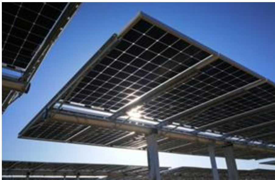
Figura 4.3: Esempio di struttura a tracker monoassiale 2p.
