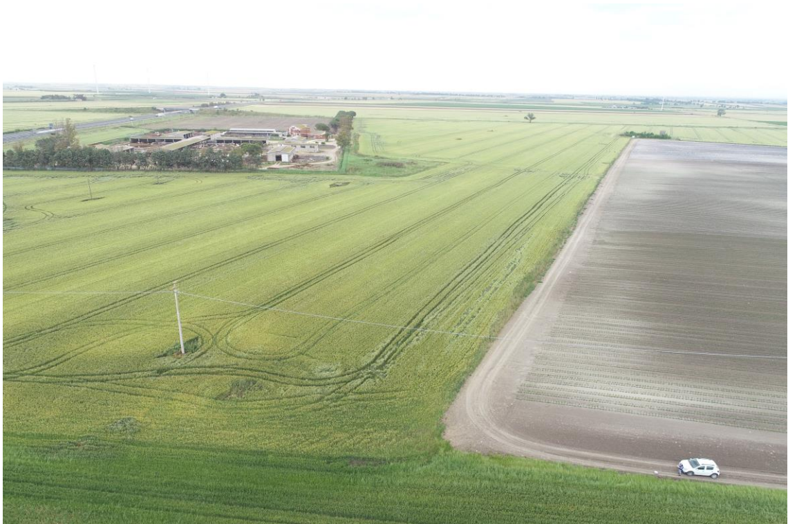
Figura 2.4: Linee elettriche e canali irrigui - Punto di presa fotografica 1.
