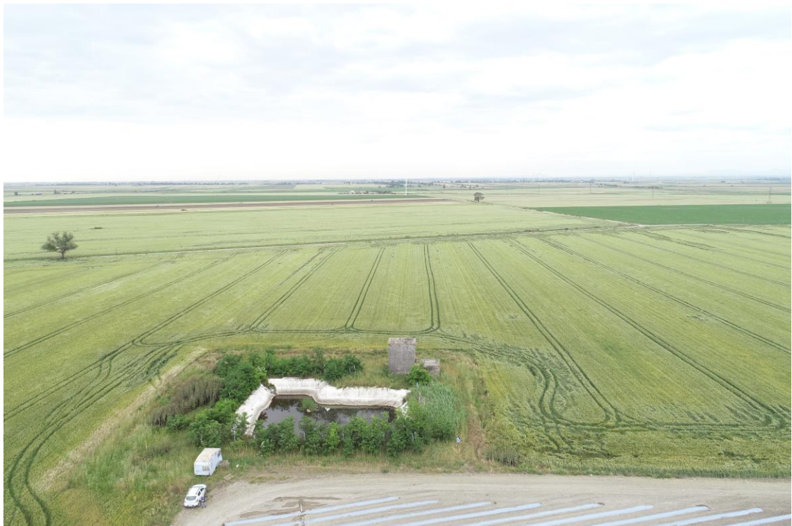
Figura 2.8: Cabina elettrica e vasca - Punto di presa fotografica 5.
