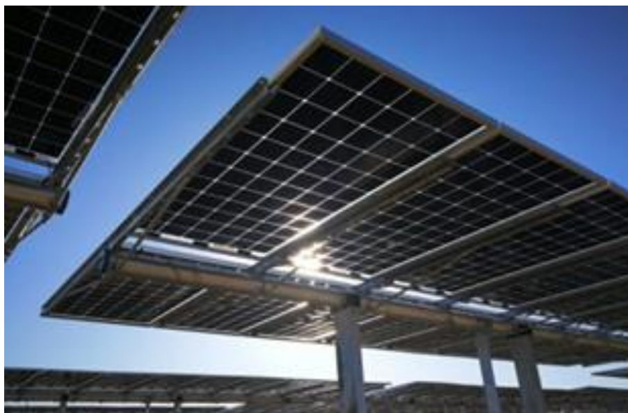
Figura 2.8: Esempio di struttura a tracker monoassiale 2p
