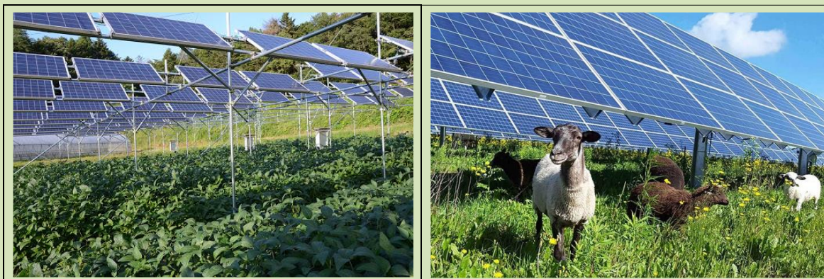
Figura 1.1: Esempi Impianti Agri-voltaici
