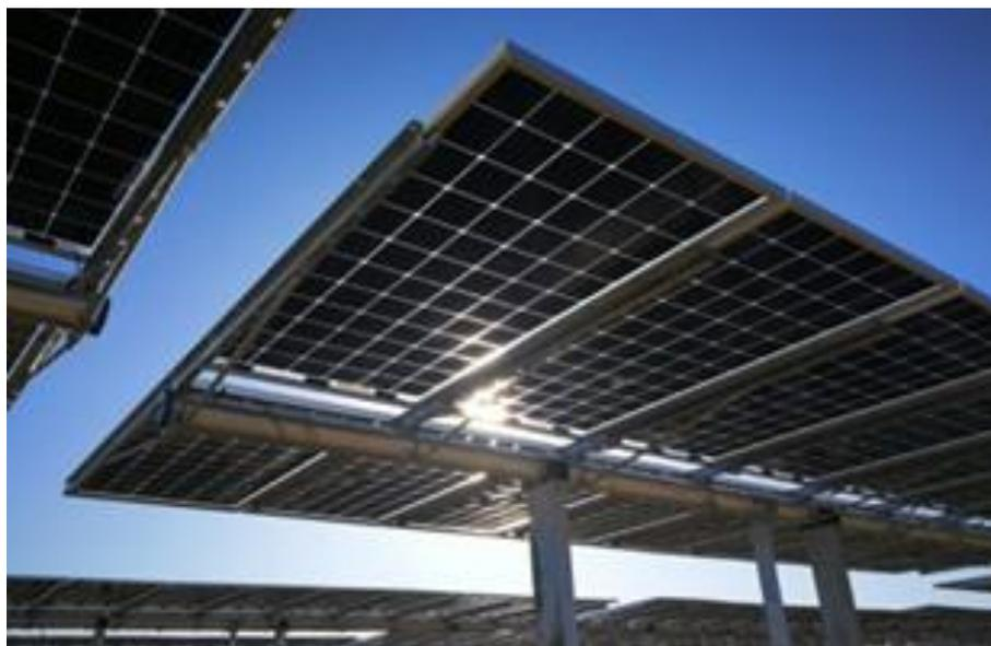
Figura 2.8: Esempio di struttura a tracker monoassiale 2p
