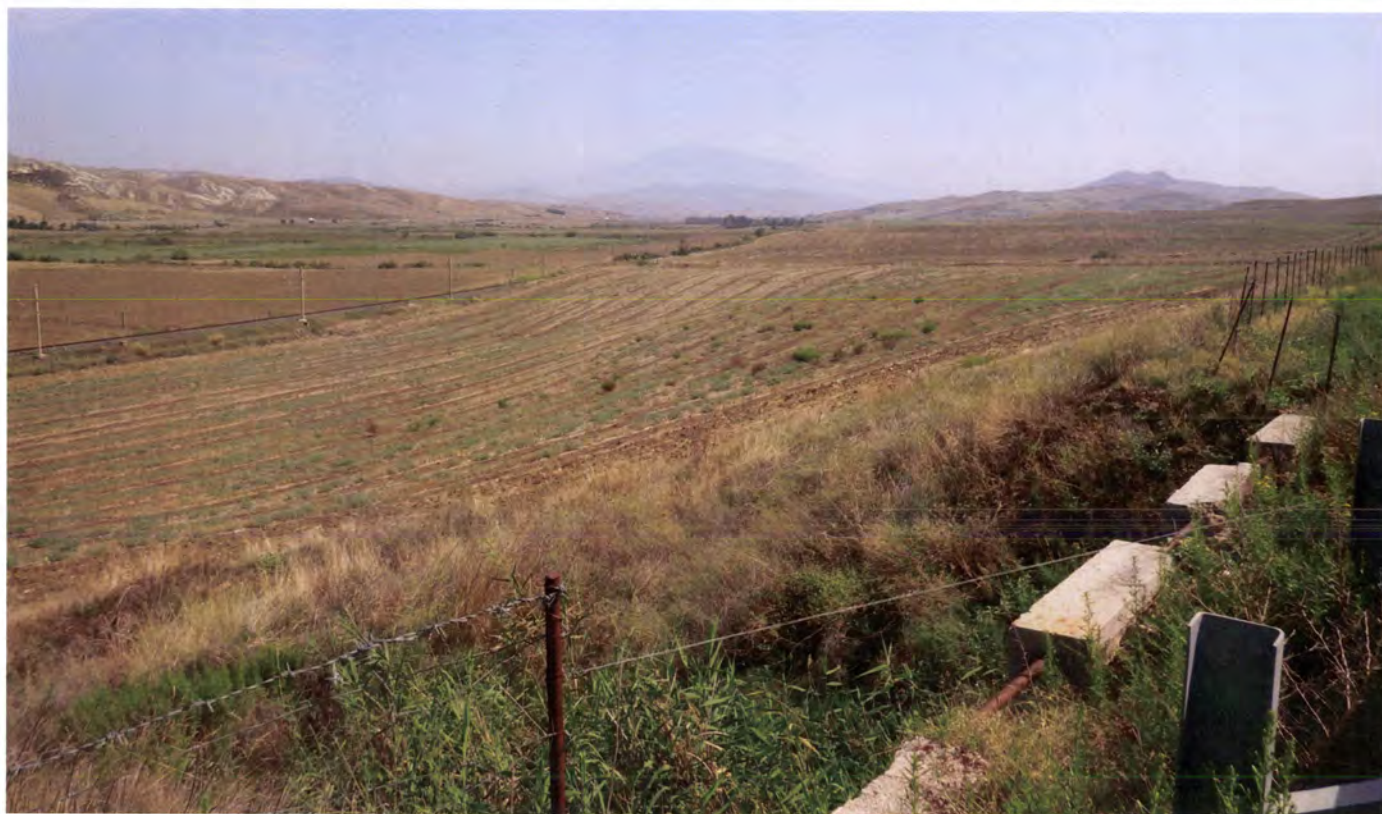
Foto 9 – Vista panoramica del tratto di intervento compreso tra il km 0+000 e il km 1+510, ripreso dalla S.S. 192.
