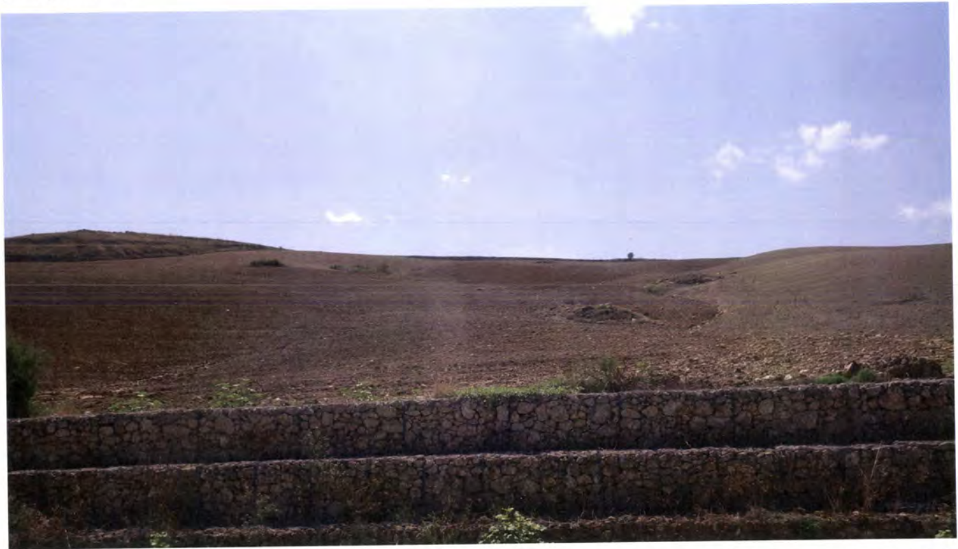
Foto 7 – Versante interessato da movimenti franosi superficiali e deformazioni viscosi delle coltri presente nei settori occidentali dell'area di intervento, immediatamente a monte della S.S. 192.
