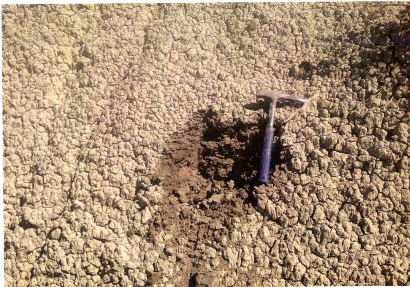
Foto 3 – Affioramento della Formazione Terravecchia nei settori occidentali dell'area di intervento, in corrispondenza dei calanchi presenti poco a Sud di Masserie Saglimbera.
