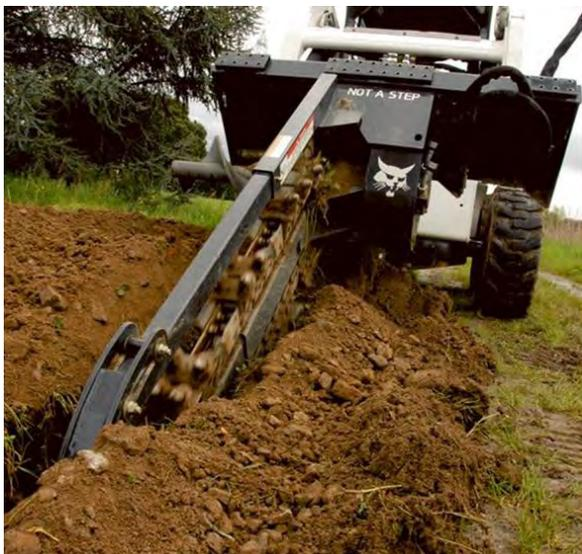
dei luoghi. In merito, **l'ottimizzazione del progetto** ha tenuto conto della grande valenza ambientale, evitando, in tal senso, di operare scavi di sbancamento e di minimizzare quelli delle trincee in cui posare il cavidotto. Nel dettaglio, saranno eseguite microtrincee tramite **un'apposita attrezzatura "trencher"** (rif. figura laterale) che riduce sia i volumi di scavo che i tempi di realizzazione. Nei terreni di che trattasi sono stimati scavi di lunghezza di oltre un chilometro al giorno.
