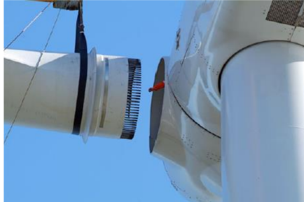
Fig. 5 Montaggio Pala
