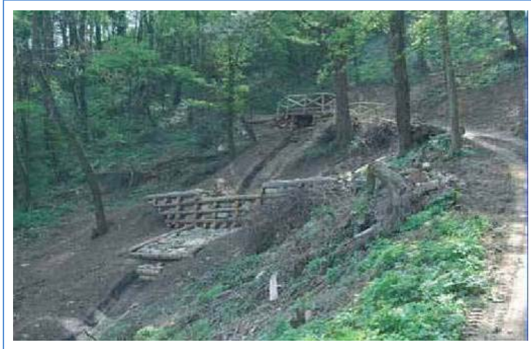
Figura 8.5 – Esempio di briglie in legname e pietrame - Fonte HE
