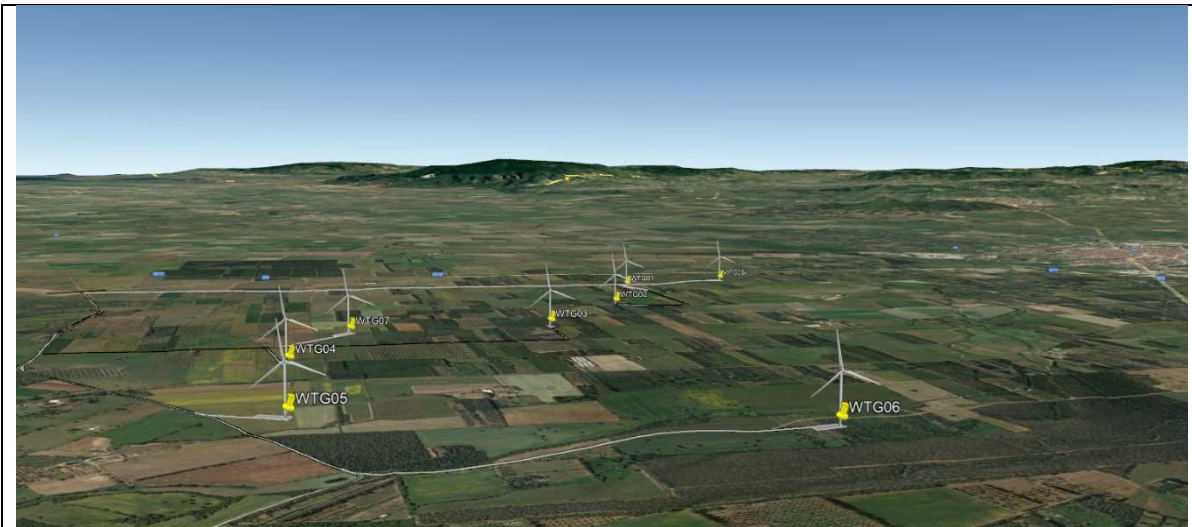
Fig. 19 - Vista degli aerogeneratori – inquadratura sud-nord
