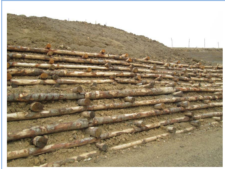
Figura 8.1 – Esempio di opera in palificate in legname - Fonte HE
