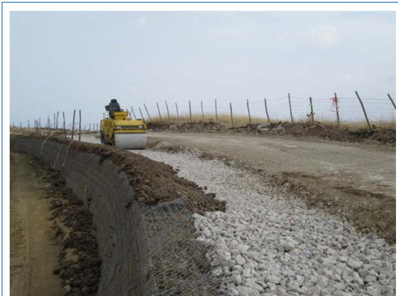
*Figura 55 – Esempio di opera in terre rinforzate - Fonte HE*
