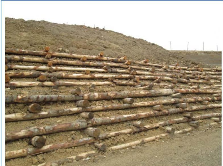
*Figura 54 – Esempio di opera in palificate in legname - Fonte HE*
