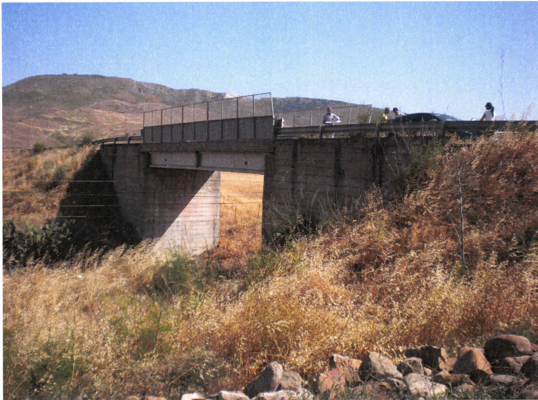
Foto 3: CVF esistente in prossimità della masseria Zito
